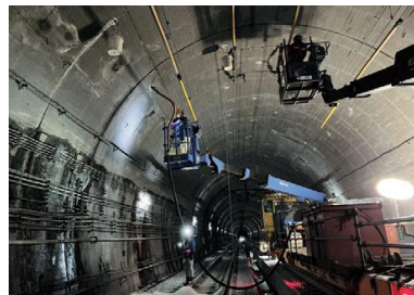
東海道新幹線大規模改修工事
