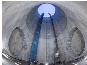
等々力非常口 立坑本体
