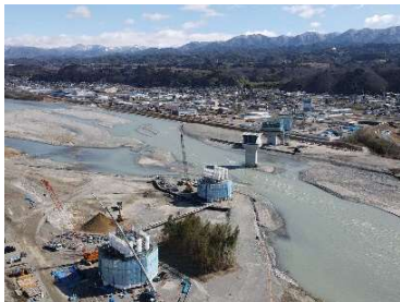
天竜川橋りょう 橋脚工
