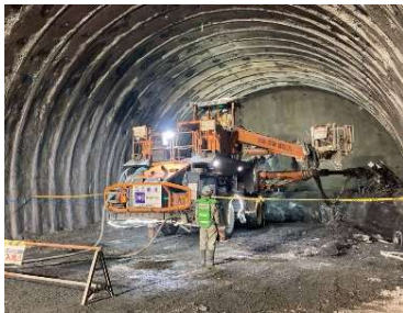
南アルプストンネル (山梨工区) 本坑掘削
