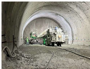
瀬戸トンネル 本坑掘削工
