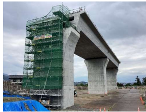
利根川公園部高架橋 全景
