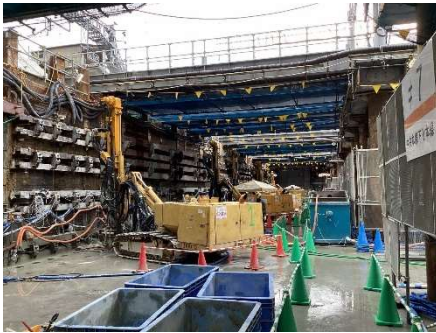
名古屋駅 中央東工区 薬液注入工 (削孔)
