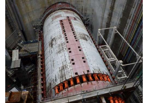
第一首都圏トンネル 梶ヶ谷工区 調査掘進
