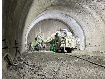
瀬戸トンネル 本坑掘削工
