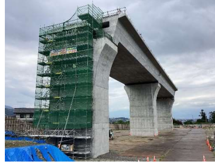
利根川公園部高架橋 全景
