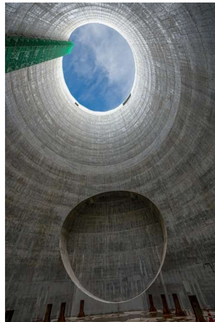
神領非常口 立坑本体の完成
