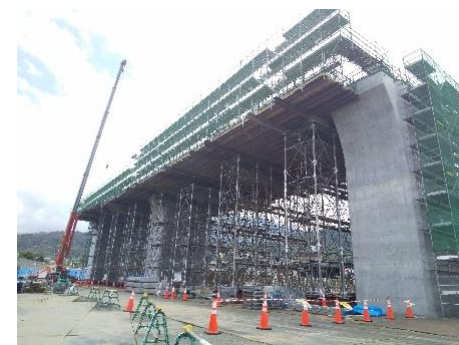
山梨県内高架橋 上部工
