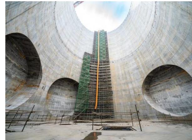
梶ヶ谷非常口
