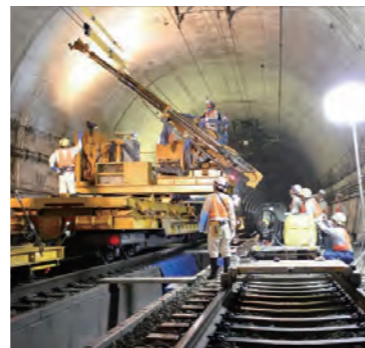
大規模改修工事
