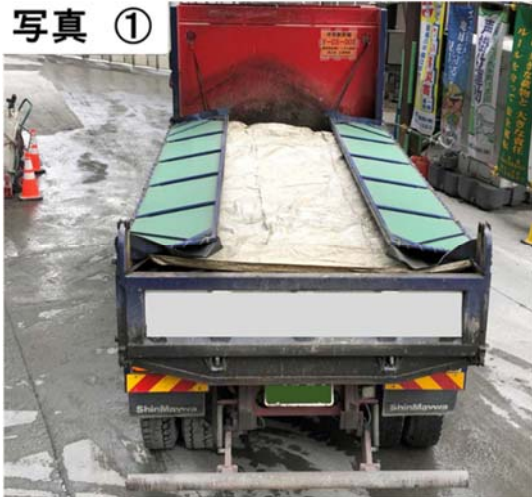
荷台への防じんシート等の設置
