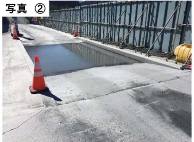
タイヤ洗浄設備の設置
