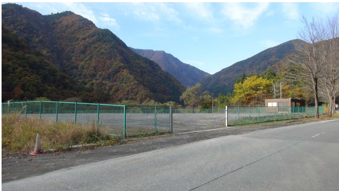
写真 2-1 塩島地区（南）発生土仮置き場の現況
