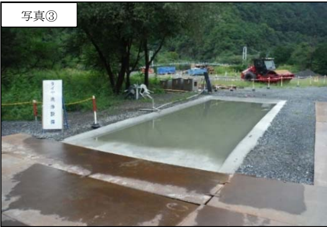
図 3-13 資材及び機械の運搬に用いる車両の影響を低減するための環境保全措置
