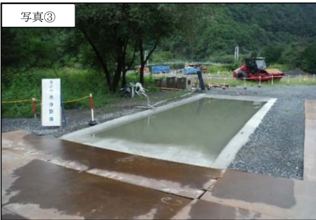
図 3-5 資材及び機械の運搬に用いる車両の運行による影響を低減するための環境保全措置
