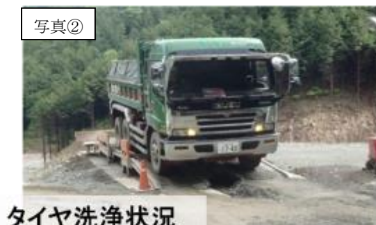
写真は、山梨リニア実験線工事での例
