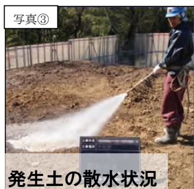
図 3-7 資材及び機械の運搬による影響を低減するための環境保全措置
