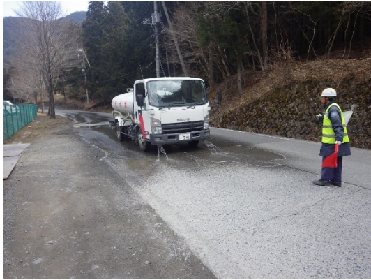
写真4-1-2-7 道路への散水
