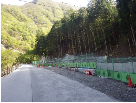
写真4-1-2-13 侵入防止柵の設置 (広河原工事施工エヤード)
