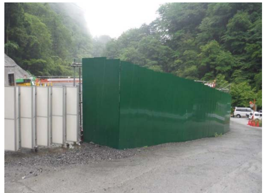
写真4-1-2-6 仮設物の色合いへの配慮 (広河原非常口仮囲い)
