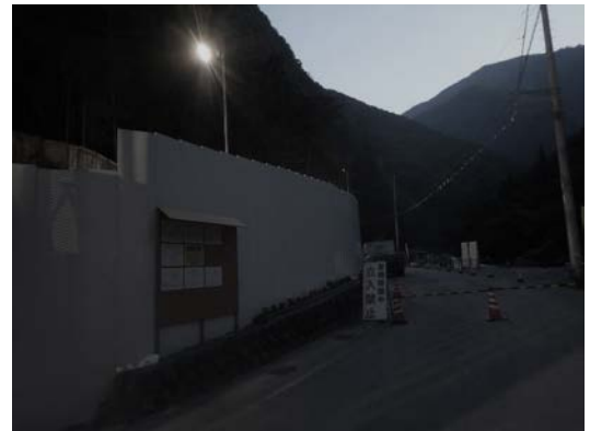
写真4-1-2-16 照明の漏れ出しの抑制 (早川非常口 LED照明点灯時)
