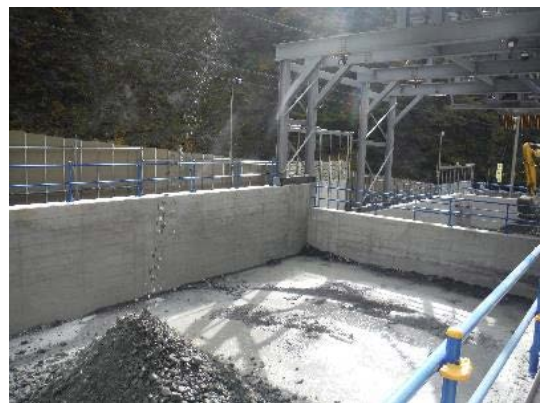
写真4-1-2-12 仮置き場における掘削土砂の 適切な管理
