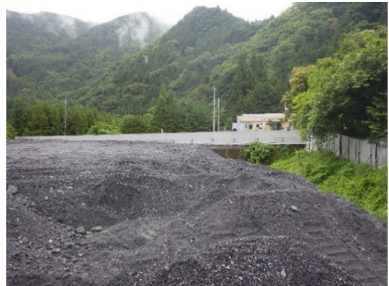
写真4-1-2-18 建設発生土の再利用 (塩島地区発生土置き場)
