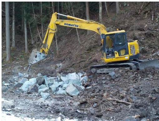
重機作業による削岩作業
