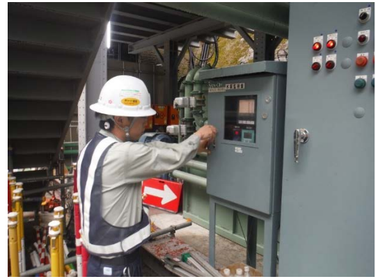
写真4-1-2-10 工事排水の監視 (濁水処理設備の監視・点検)
