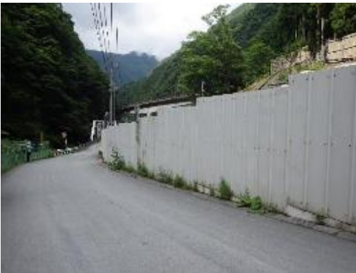
写真4-1-2-5 仮囲いの設置 (早川非常口)
