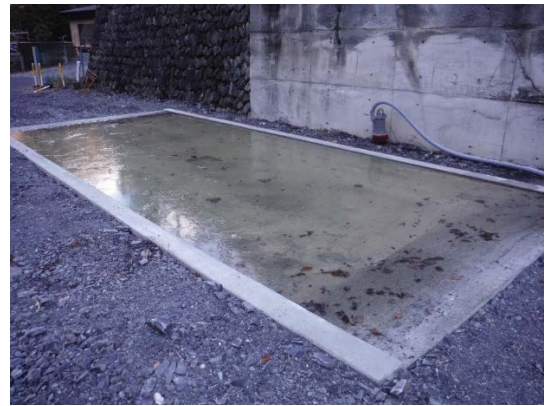
写真4-1-4-4 タイヤ洗浄状況
