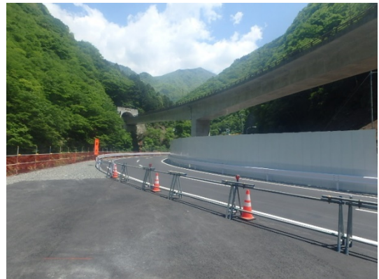
写真4-1-1-6 仮囲い（防音シート、侵入 防止柵）設置状況
