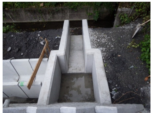
写真4-1-3-6 工事用排水の適切な処理
