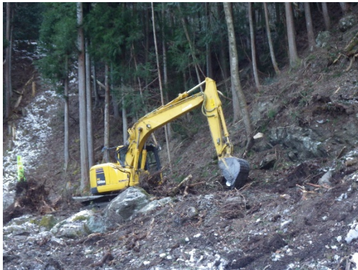
重機作業による整地作業
