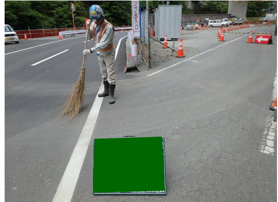
写真4-1-1-4 清掃実施状況
