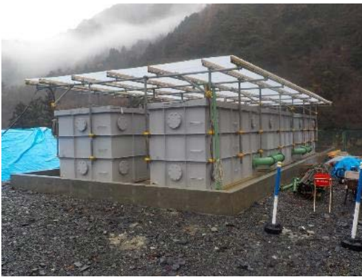
写真4-1-4-5 工事排水の適切な処理
