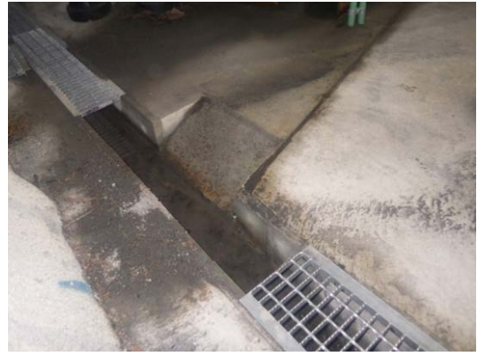
写真4-1-2-14 小動物が脱出可能な 側溝の設置
