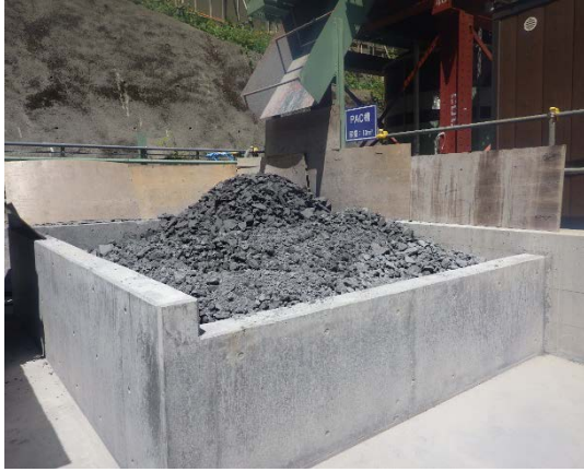
写真4-1-2-19 建設汚泥の脱水処理
