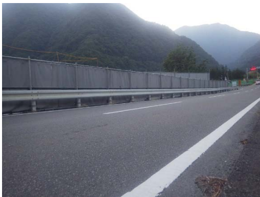
写真4-1-3-5 防音シートの設置状況
