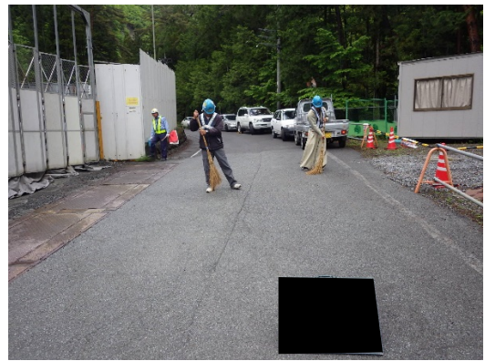
写真4-1-2-4 工事現場の清掃及び散水
