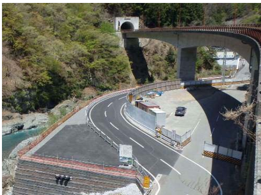
写真4-1-1-5 清掃実施状況 (清掃後 下流側より)
