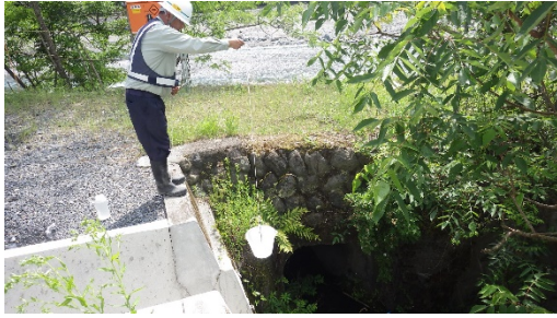
写真4-1-3-7 工事排水の監視
