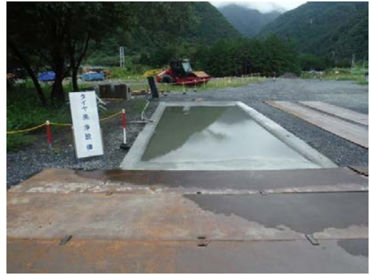
写真4-1-3-4 タイヤ洗浄状況
