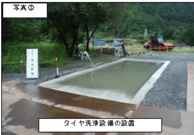
図 3-4 資材及び機械の運搬に用いる車両の運行による影響を低減するための環境保全措置
