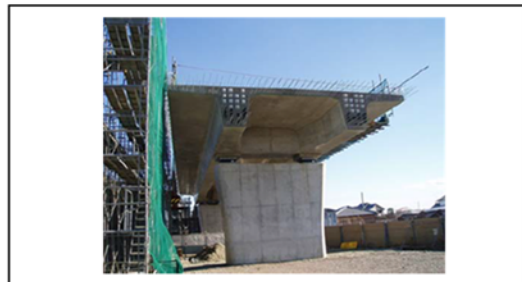
図 2-10 上部工（固定式支保工）の施工手順
