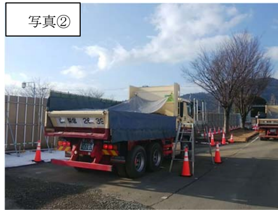
防じんシートの敷設
