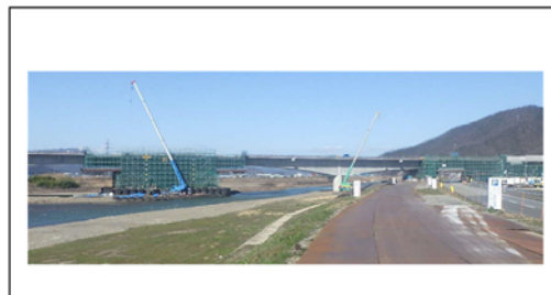
図 2-9 上部工（張出架設工）の施工手順
