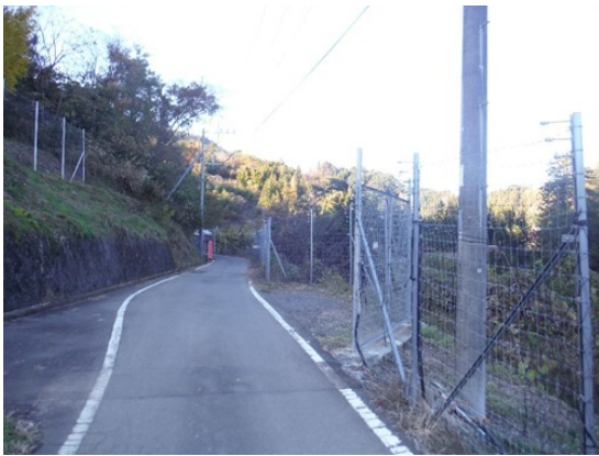
写真 2-7 既存町道整備計画地⑦
