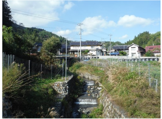
写真 2-6 工事用道路整備計画地⑥
