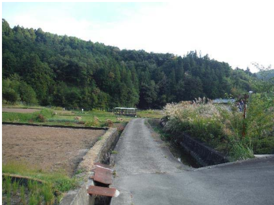
写真 2-1 工事用道路整備計画地①
