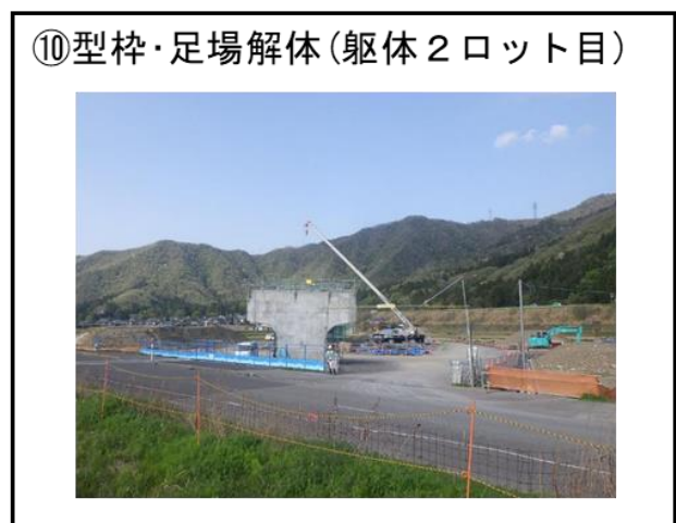
図 2-14 (3) 下部工 (直接基礎) の施工手順
