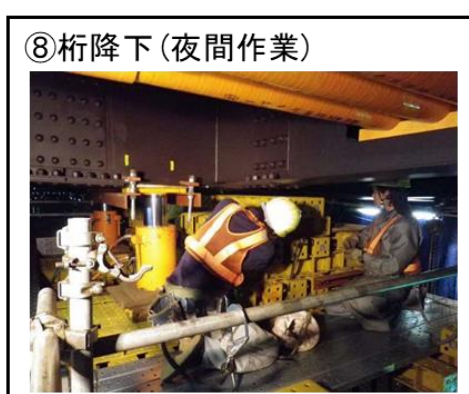
図 2-16(2) 上部工(送出し架設工法)の施工手順
