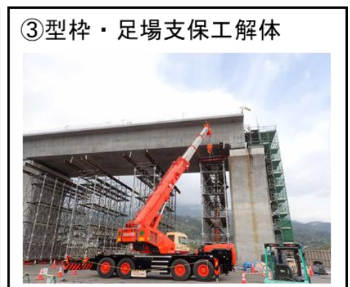
図 2-18 上部工（固定式支保工架設工法）の施工手順
