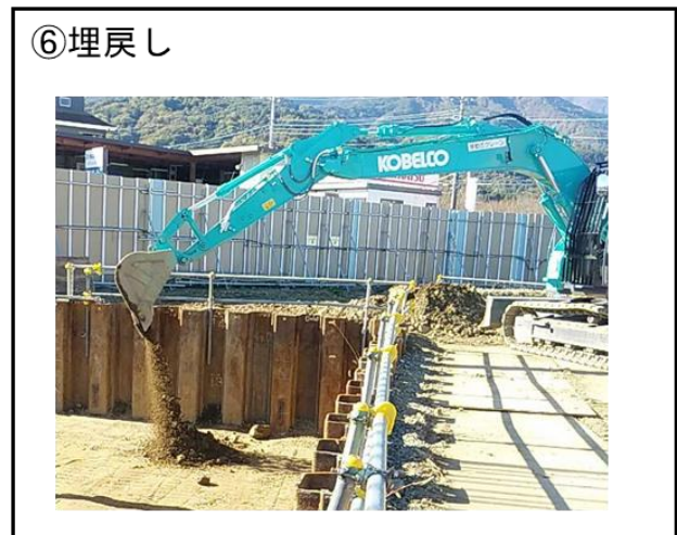
図 2-12 (2) 下部工（深礎基礎）の施工手順
