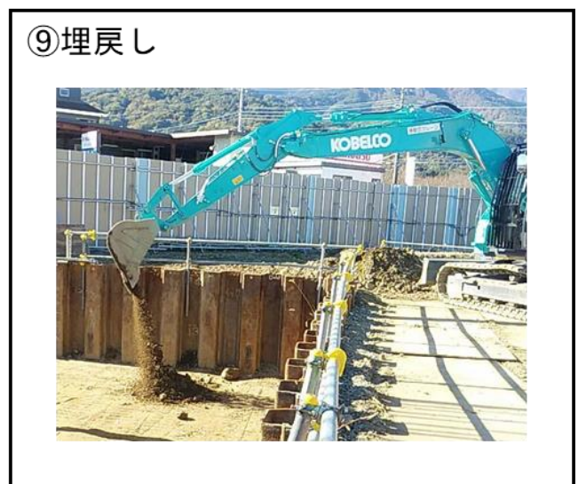
図 2-10 (3) 下部工 (ニューマチックケーソン基礎) の施工手順
