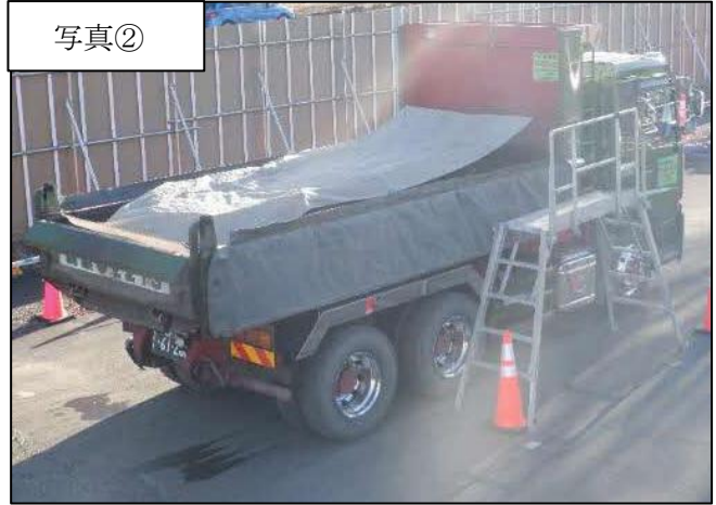
防じんシートの敷設
