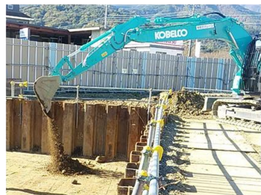
図 2-14 (2) 下部工（直接基礎）の施工手順
