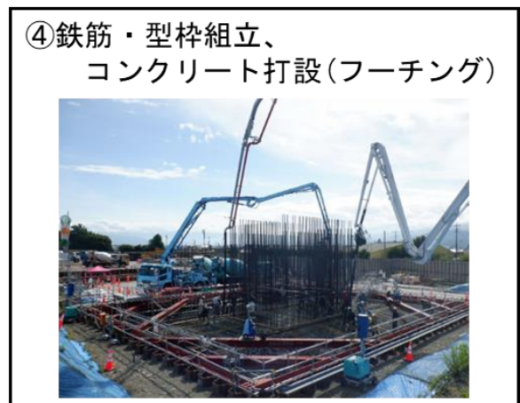
図 2-14 (1) 下部工（直接基礎）の施工手順
