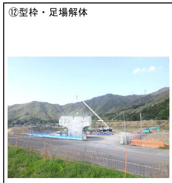
図 2-10 (4) 下部工 (ニューマチックケーソン基礎) の施工手順
