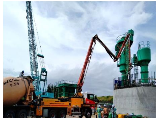
図 2-10 (2) 下部工（ニューマチックケーソン基礎）の施工手順
