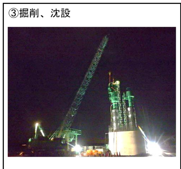
図 2-10 (1) 下部工（ニューマチックケーソン基礎）の施工手順
