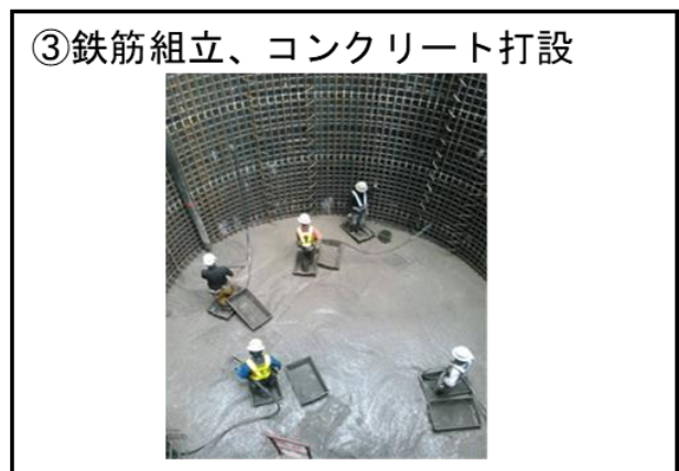
図 2-12 (1) 下部工（深礎基礎）の施工手順
