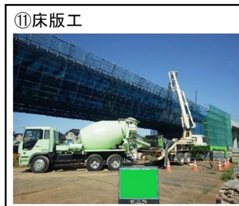
図 2-16 (3) 上部工（送出し架設工法）の施工手順
