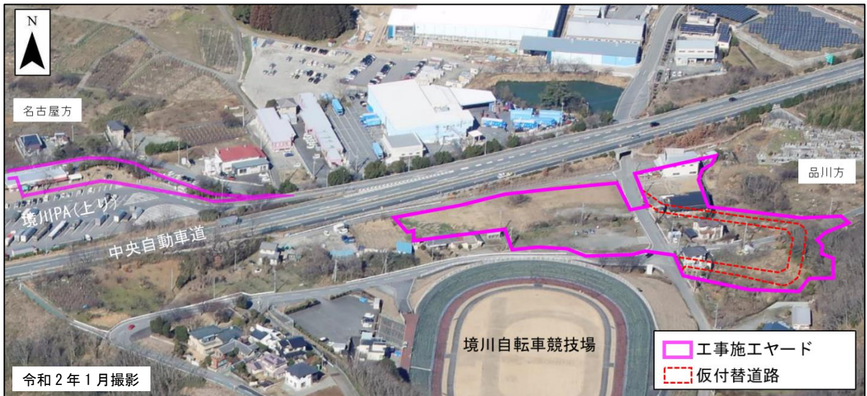
写真 2-1 工事位置の状況
