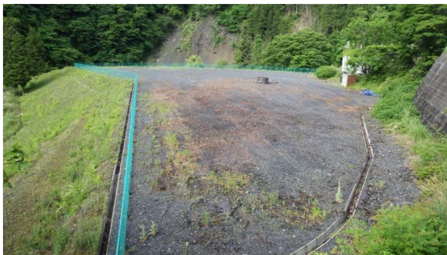
写真 2-1 雨畑地区発生土仮置き場計画地の現況(1)
