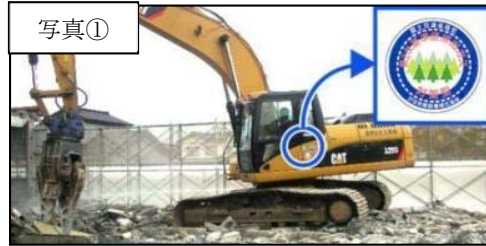
排出ガス対策型建設機械の採用
