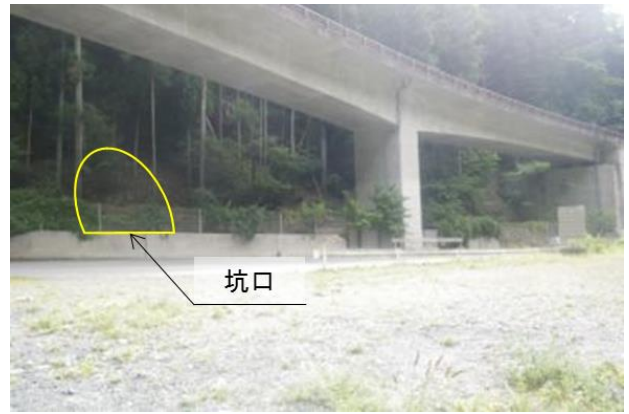
写真 2-2 早川東非常口ヤードの工事着手前の状況（非常口正面）
