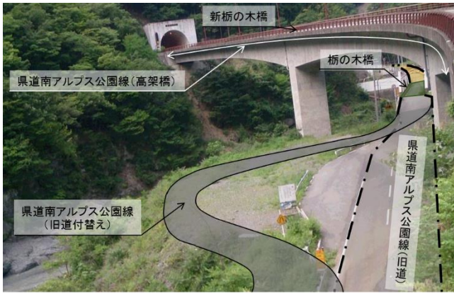
写真 2-1 早川東非常口ヤードの工事着手前の状況（全景）
