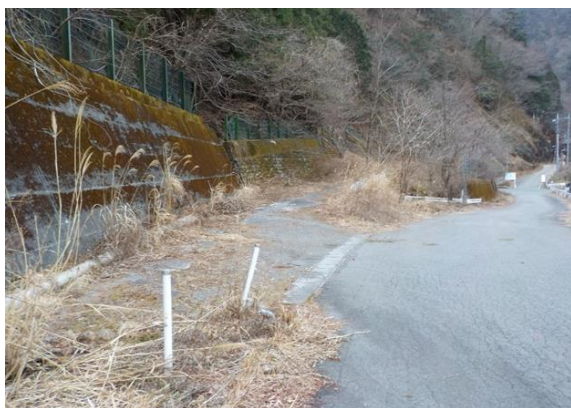
写真 2-3 工事ヤード（南）の現況（全景）
