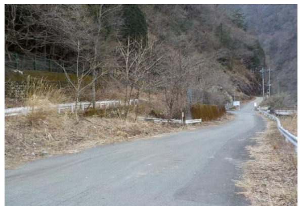
写真 2-4 工事ヤード（南）の現況（正面）
