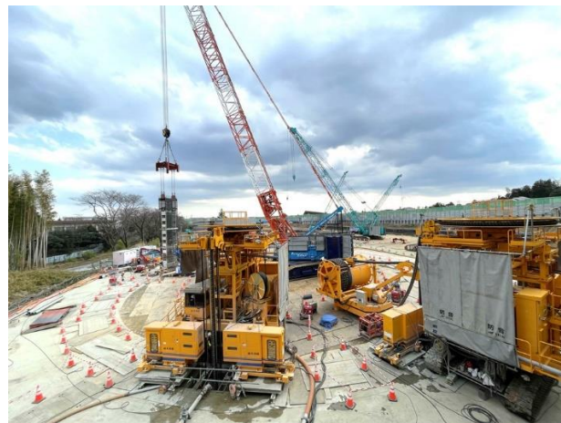
写真 3-4-6 地中連続壁工の状況 (令和 5 年 3 月時点)
