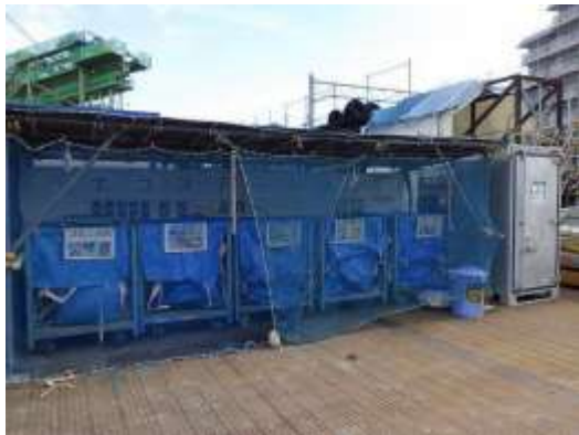
写真-2-2 副産物の分別、再資源化の状況 (地点 02)
