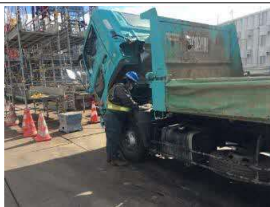
写真-1-2 資材及び機械の運搬に用いる車両の点検及び整備による性能維持 (地点 07)
