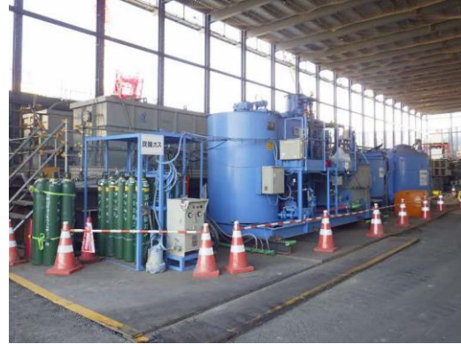
写真-1-2 工事排水の処理状況（地点 05）
