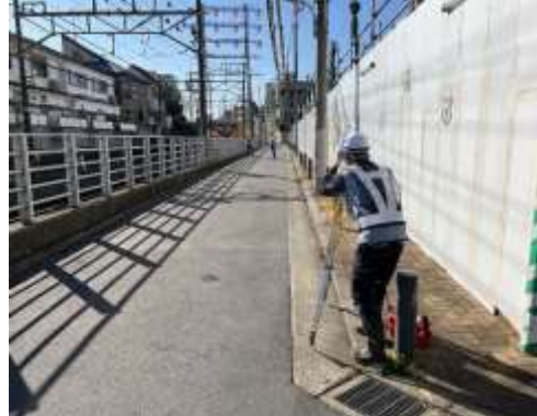
写真-2-1 山留め材及び周辺地盤の計測管理状況（地点 03）
