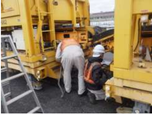
写真-2-1 資材及び機械の運搬に用いる車両の点検及び整備による性能維持の状況（地点 01）
