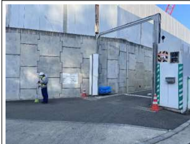
写真-2-2 車両出入り口の散水・清掃 (地点 06)
