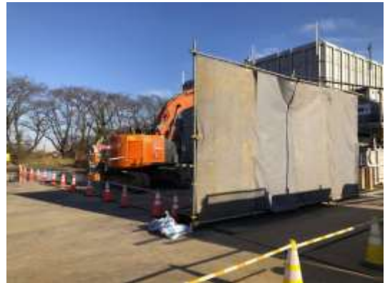
写真-4 防音シートの設置（地点 01）
