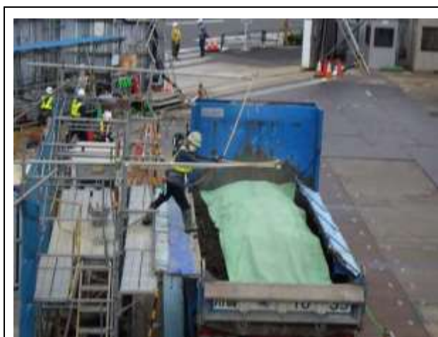
写真-1 荷台への防じんシート敷設の状況 (地点 03)
