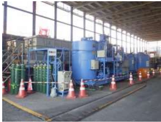
写真-3 濁水処理設備の設置状況（地点 02）
