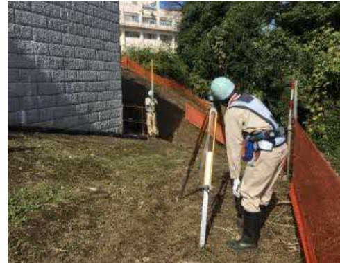
写真-2-3 山留め材及び周辺地盤の計測管理状況（地点 06）
