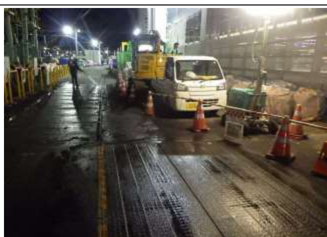
写真-2-1 車両の出入り口、周辺通路清掃の状況 (地点 01、02)
