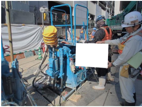
写真-2 薬液注入工の状況（地点 01）
