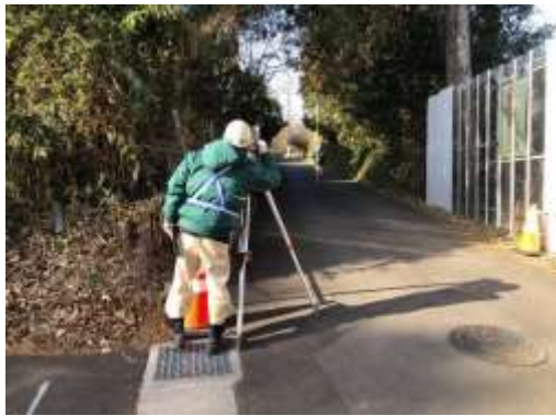
写真-2-2 山留め材及び周辺地盤の計測管理状況（地点 04）
