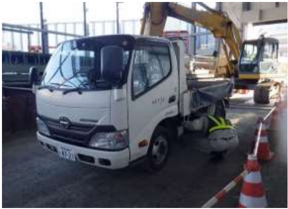
写真-1-1 車両の点検及び整備 (地点 06)
