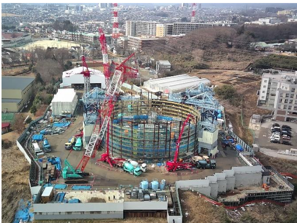
写真 3-4-9(1) 構築（コンクリート打設）の状況 （令和 3 年 12 月時点）
