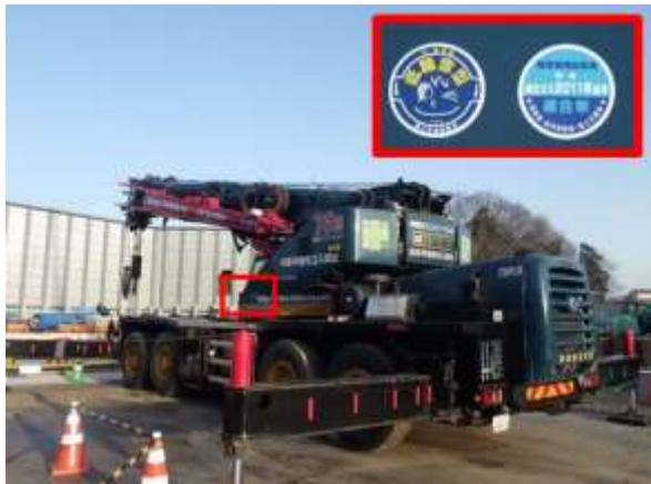
写真-5 低騒音型建設機械の採用（地点 02）
