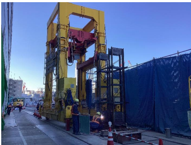
写真 3-4-1(1) 地中連続壁工の状況 (令和 5 年 3 月時点)
