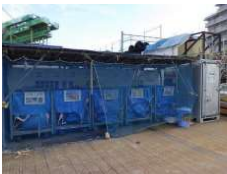
写真-5-1 副産物の分別、再資源化の状況（地点 02）
