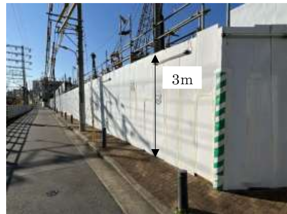
写真-2-2 仮囲い・防音シート等の設置状況 (地点 03)
