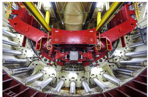
写真 3-4-8(2) シールド機の試運転状況 (令和4年12月時点)
