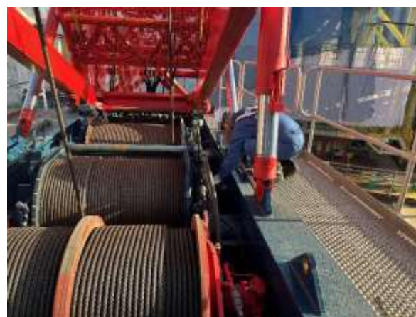
写真-1-2 建設機械の点検及び整備の状況 (地点 05)
