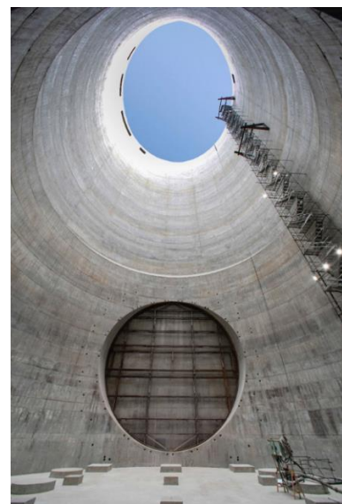
写真 3-4-7(2) 底版から見た完成状況 (令和2年12月時点)
