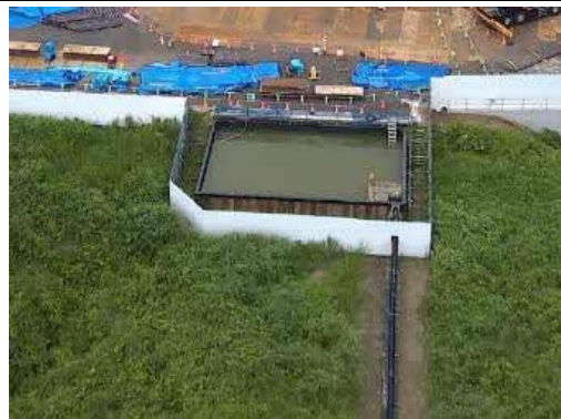
写真-1-3 工事排水の処理状況（地点 06）
