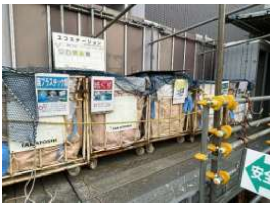
写真-2-2 副産物の分別、再資源化の状況 (地点 03)
