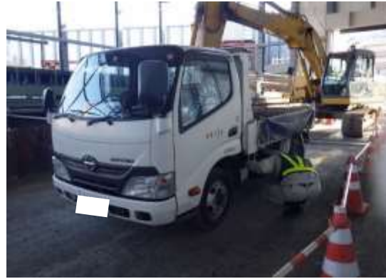
写真-2-2 資材及び機械の運搬に用いる車両の点検及び整備による性能維持の状況（地点 05）
