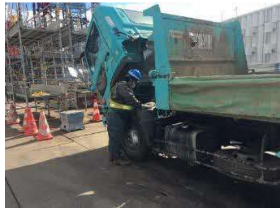
写真-1-2 資材及び機械の運搬に用いる車両の点検及び整備による性能維持 (地点 07)
