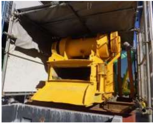
写真-1 建設汚泥の脱水処理の状況 (地点 01)
