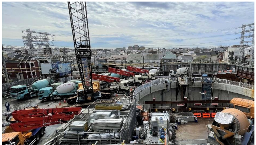
写真 3-4-5(2) 躯体構築工（コンクリート打設）の状況 (令和 5 年 3 月時点)
