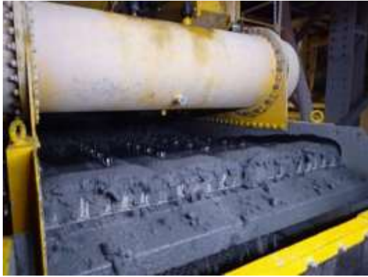
写真-1 建設汚泥の脱水処理の状況 (地点 03)
