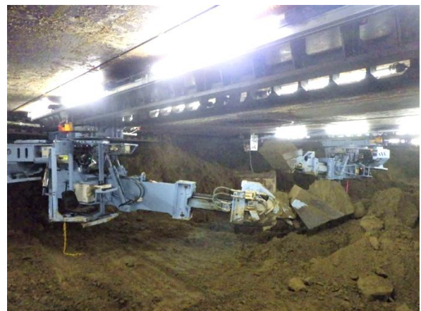
写真 3-4-9(2) 掘削の状況 （令和 5 年 3 月時点）
