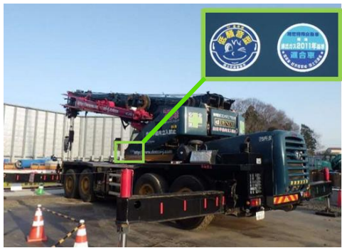
写真-3 低騒音・低振動型の建設機械の採用（地点 02）
