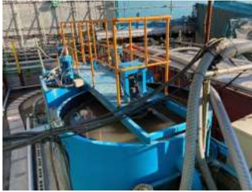
写真-1-1 工事排水の処理状況（地点 02）
