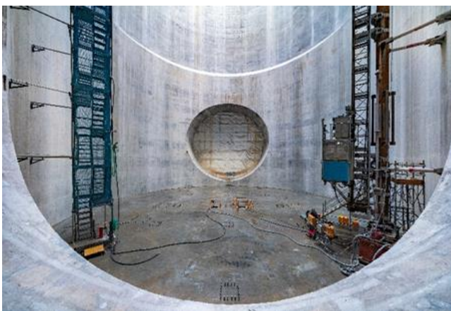
写真 3-4-2(1) 坑口から見た完成状況 (令和元年 12 月時点)
