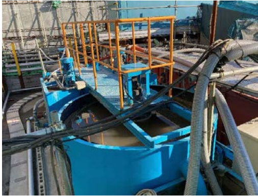
写真-1-1 工事排水の処理状況（地点 02）
