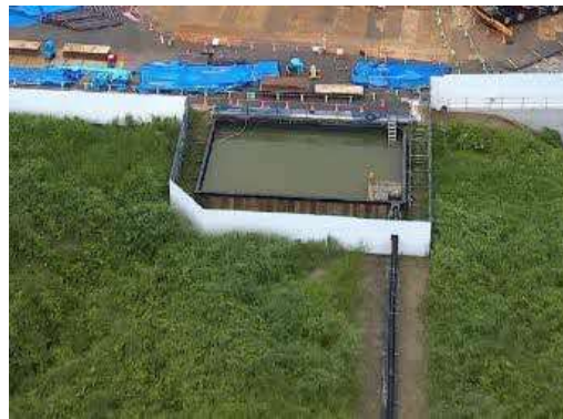
写真-1-3 工事排水の処理状況（地点 06）
