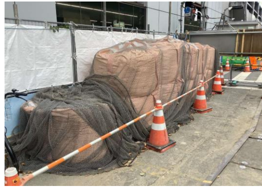
写真-3 発生土の仮置き状況（地点 01）
