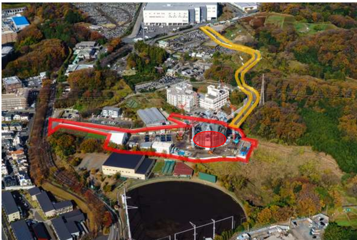
写真 ヤードの周辺状況（上小山田非常口）
