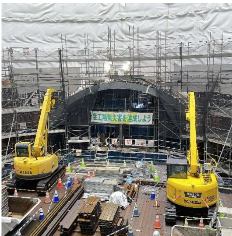
写真 3-4-5(1) 躯体構築工の状況 (令和 5 年 3 月時点)
