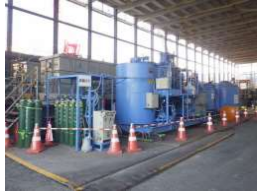
写真-1-2 工事排水の処理状況（地点 05）
