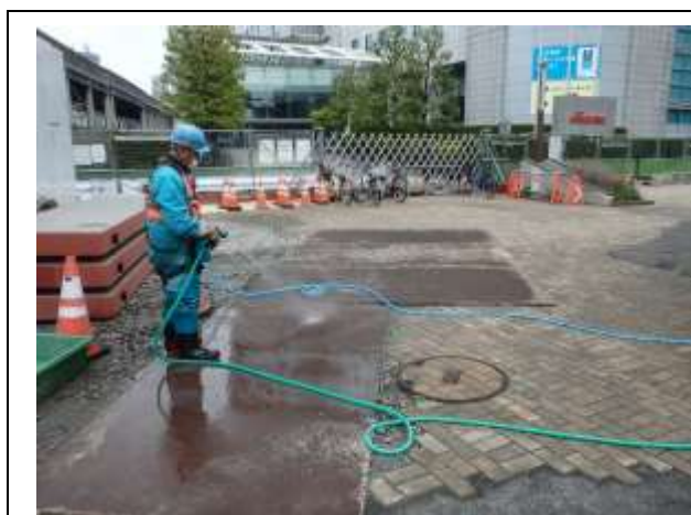
写真-1-1 工事現場の清掃、散水の状況 (地点 01)
