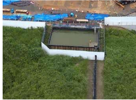
写真-2 仮設沈砂池の設置（地点 03）
