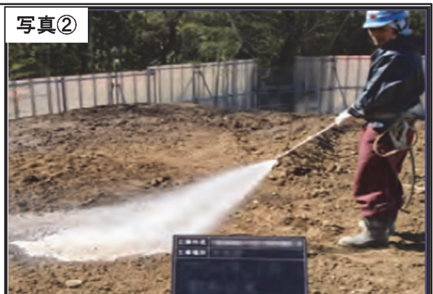
工事施工ヤード等の清掃、散水
