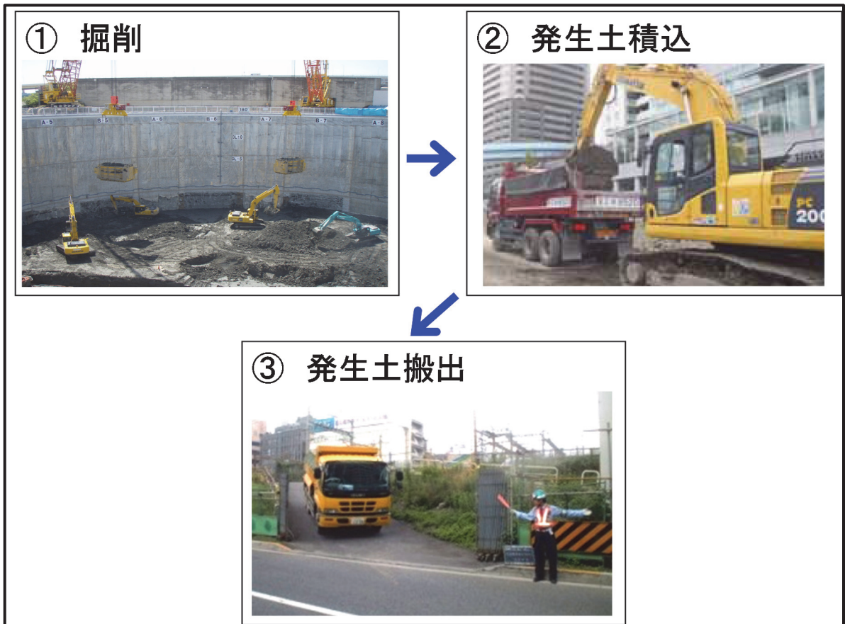
図 2-3 (4) 掘削工の施工手順 (写真は類似工事の例)
