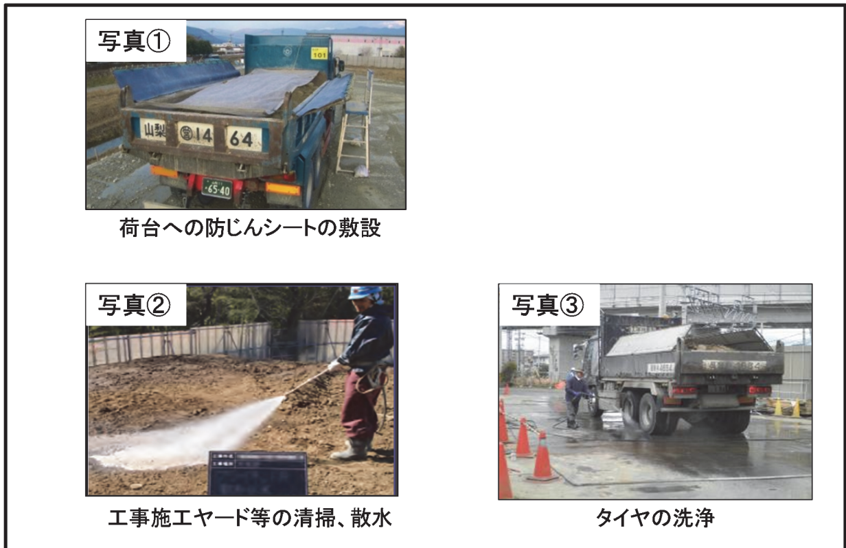
図 3-4 資材及び機械の運搬による影響を低減するための環境保全措置
