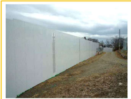
写真⑤: 仮囲いの設置状況
