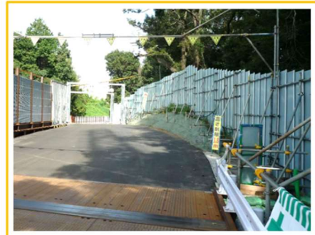
写真⑥: 仮囲いの設置状況
