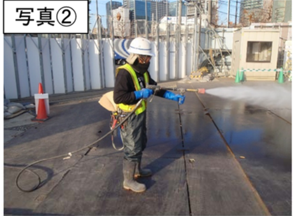
車両の出入口の清掃、散水
