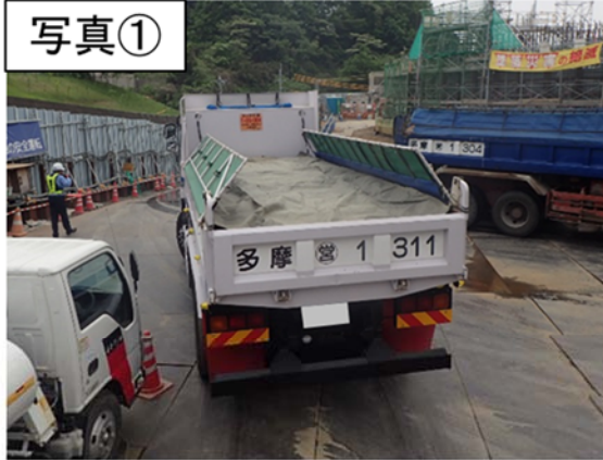
荷台への防じんシートの設置
