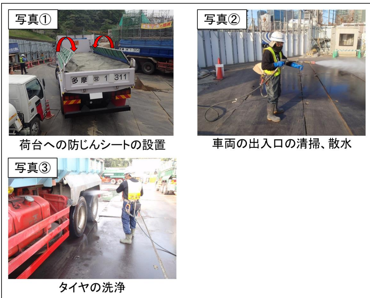
図 3-5(1) 資材及び機械の運搬に用いる車両の運行による影響を低減するための環境保全措置
