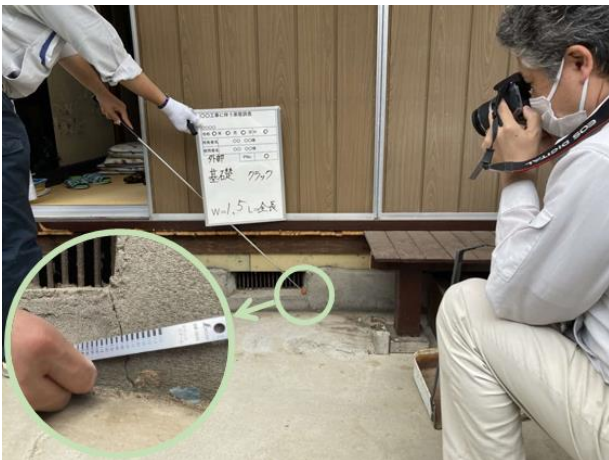
参考図 2-10 外壁・基礎調査
