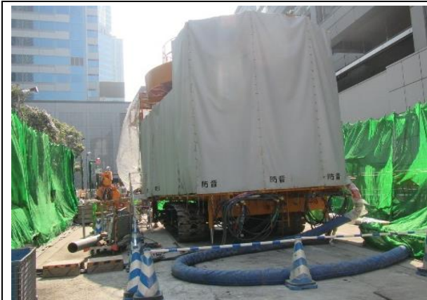
写真4-1-1-1 仮囲い・防音シート等の設置
