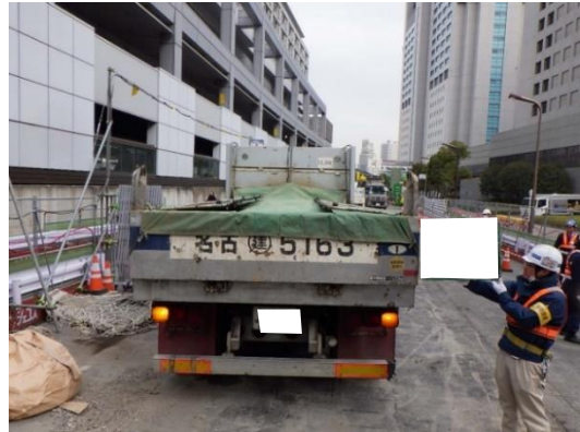
写真4-1-1-14 荷台への防じんシート敷設及び散水
