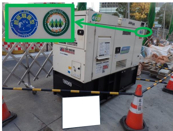
写真4-1-1-3 低騒音型建設機械の採用
