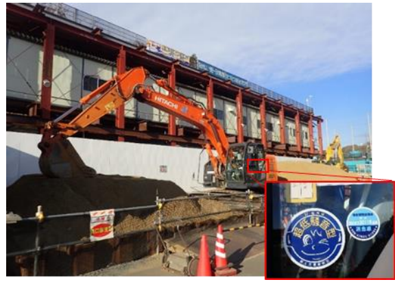
写真4-1-4-2 排出ガス対策型建設機械の採用、低騒音型建設機械の採用
