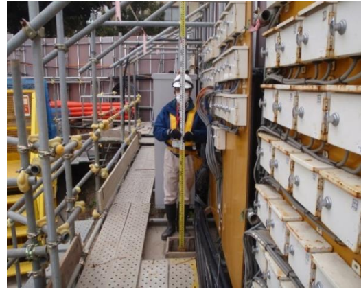
写真4-1-2-8 山留め材及び周辺地盤の計測管理
