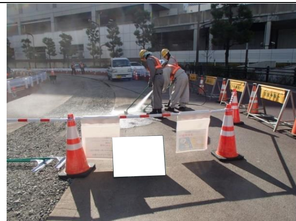
写真4-1-1-5 工事現場の清掃、散水
