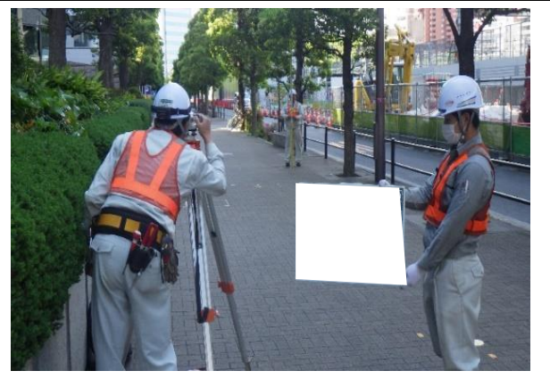
写真4-1-1-10 山留め材及び周辺地盤の計測管理
