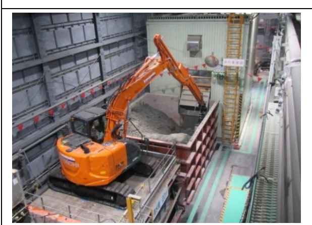
写真4-1-1-11 建設汚泥の脱水処理
