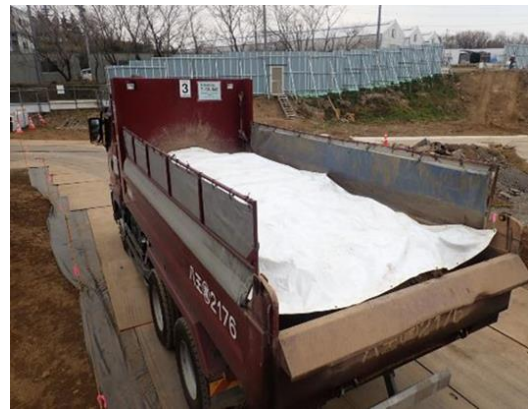
写真4-1-5-10 荷台への防じんシート敷設及び散水
