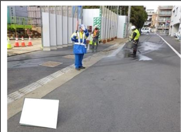
写真4-1-3-13 資材及び機械の運搬に用いる車両の出入口、周辺道路の清掃及び散水、タイヤの洗浄
