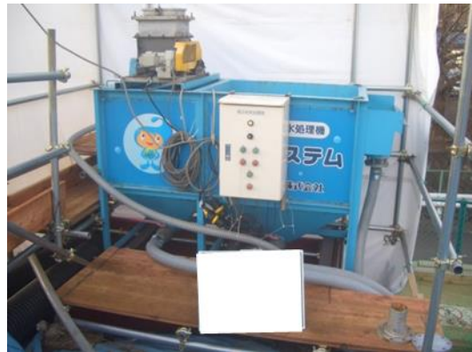
写真4-1-4-6 工事排水の適切な処理
