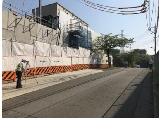
写真4-1-4-8 山留め材及び周辺地盤の計測管理
