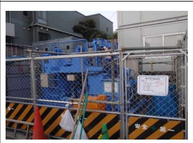
写真4-1-2-6 工事排水の適切な処理
