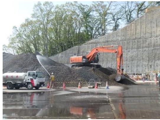
写真4-1-4-4 工事現場の清掃、散水
