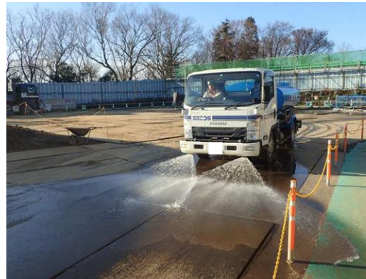
写真4-1-5-4 工事現場の清掃、散水
