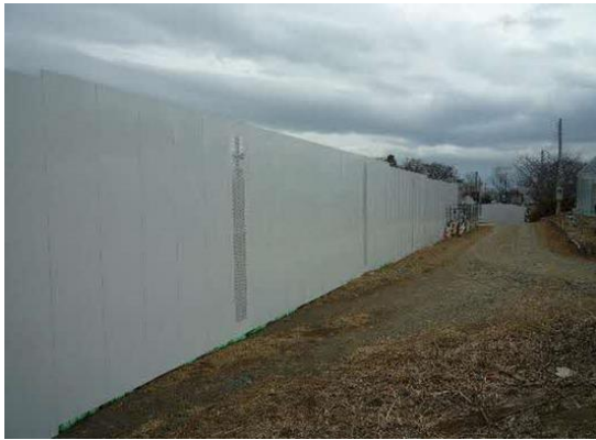
写真4-1-5-1 仮囲い・防音シート等の設置
