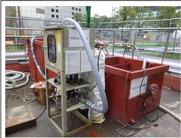
写真4-1-1-7 工事排水の適切な処理
