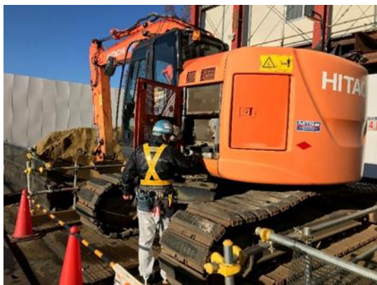
写真4-1-4-3 建設機械の点検及び整備による性能維持
