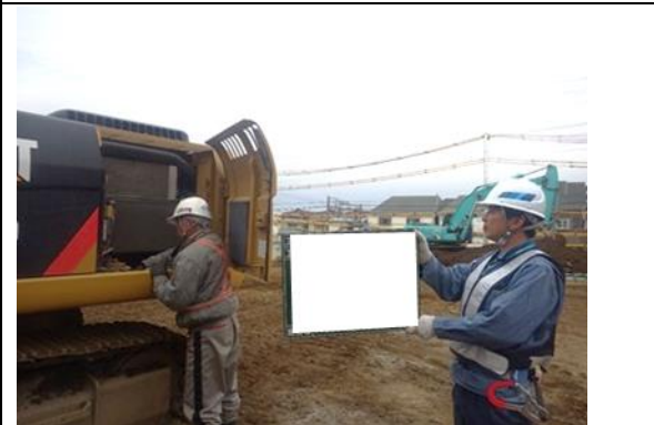
写真4-1-3-3 建設機械の点検及び整備による性能維持
