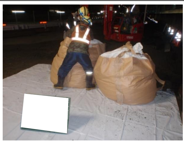
写真4-1-1-8 ヤード内で一時的に存置する発生土の適切な管理
