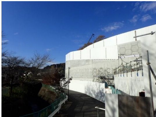
写真4-1-4-1 仮囲い・防音シート等の設置
