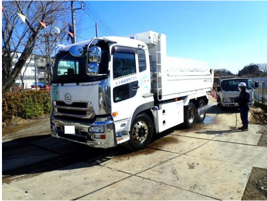
写真4-1-5-7 外来種の拡大抑制、資材及び機械の運搬に用いる車両の出入口、周辺道路の清掃及び散水、タイヤの洗浄
