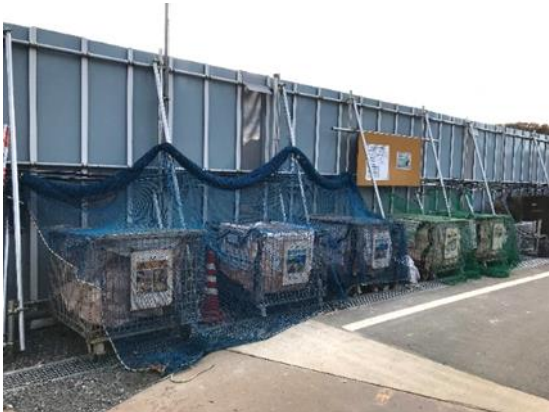
写真4-1-4-11 副産物の分別、再資源化
