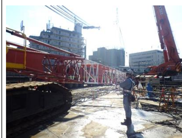
写真4-1-2-3 建設機械の点検及び整備による性能維持
