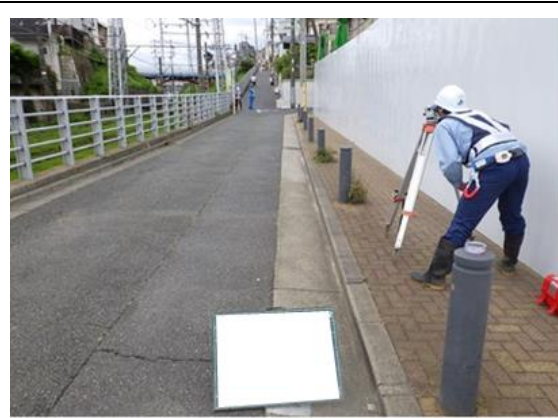
写真4-1-3-8 山留め材及び周辺地盤の計測管理
