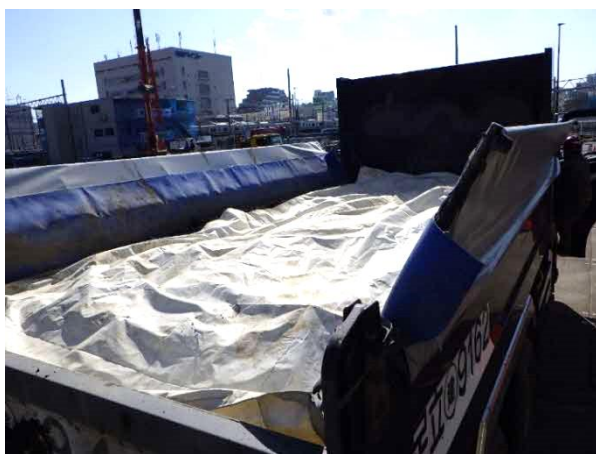
写真4-1-2-11 荷台への防じんシート敷設及び散水
