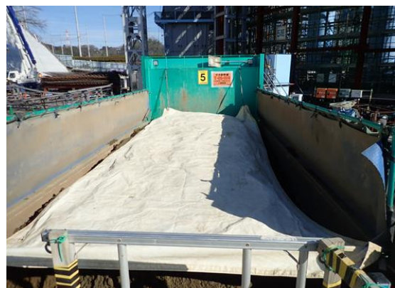
写真4-1-4-12 荷台への防じんシート敷設及び散水
