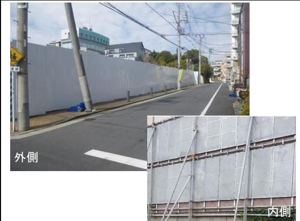
写真4-1-3-1 仮囲い・防音シート等の設置
