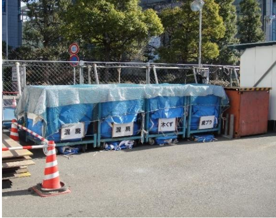
写真4-1-1-13 副産物の分別、再資源化
