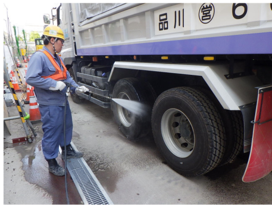
写真4-1-1-16 資材及び機械の運搬に用いる車両の出入口、周辺道路の清掃及び散水、タイヤの洗浄
