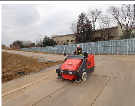
写真4-1-5-4 工事現場の清掃、散水
