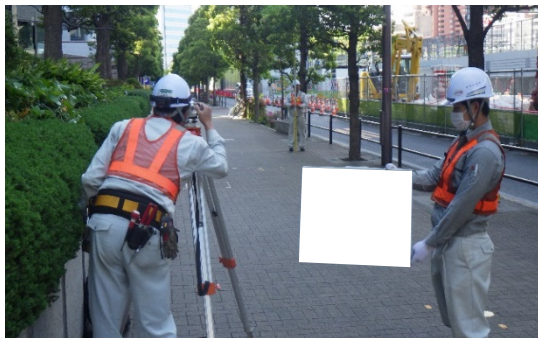
写真4-1-1-11 山留め材及び周辺地盤の計測管理
