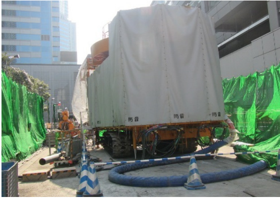
写真4-1-1-1 仮囲い・防音シート等の設置
