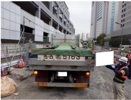
写真4-1-1-15 荷台への防じんシート敷設及び散水
