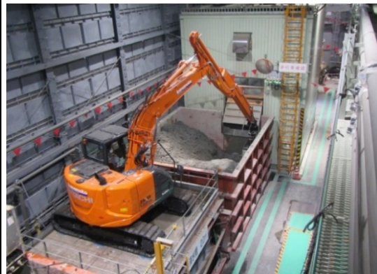
写真4-1-1-12 建設汚泥の脱水処理
