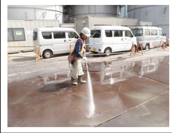
写真4-1-2-4 工事現場の清掃、散水
