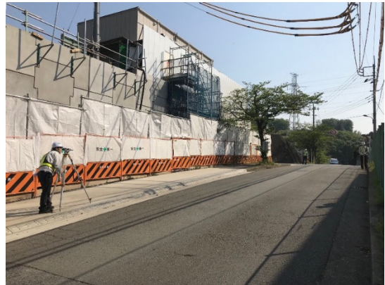
写真4-1-4-8 山留め材及び周辺地盤の計測管理
