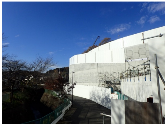
写真4-1-4-1 仮囲い・防音シート等の設置
