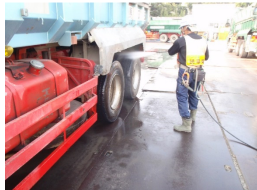
写真4-1-2-12 資材及び機械の運搬に用いる車両の出入口、周辺道路の清掃及び散水、タイヤの洗浄
