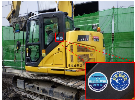
写真4-1-1-3 低騒音型建設機械の採用
