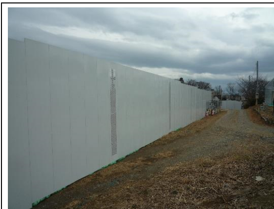
写真4-1-5-1 仮囲い・防音シート等の設置
