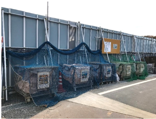
写真4-1-4-11 副産物の分別、再資源化
