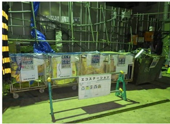
写真4-1-3-9 副産物の分別、再資源化
