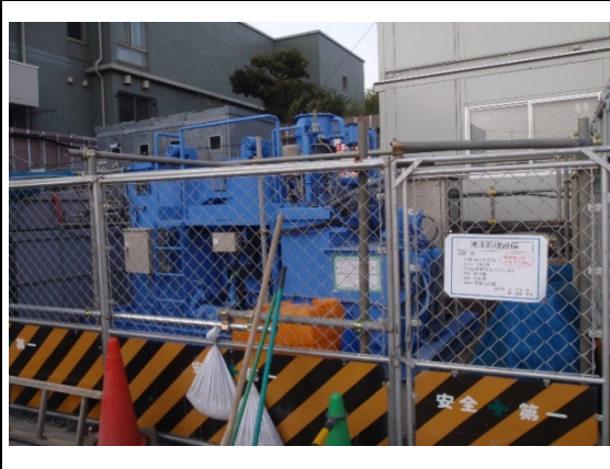
写真4-1-2-6 工事排水の適切な処理
