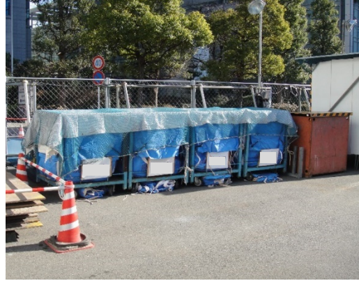
写真4-1-1-14 副産物の分別、再資源化
