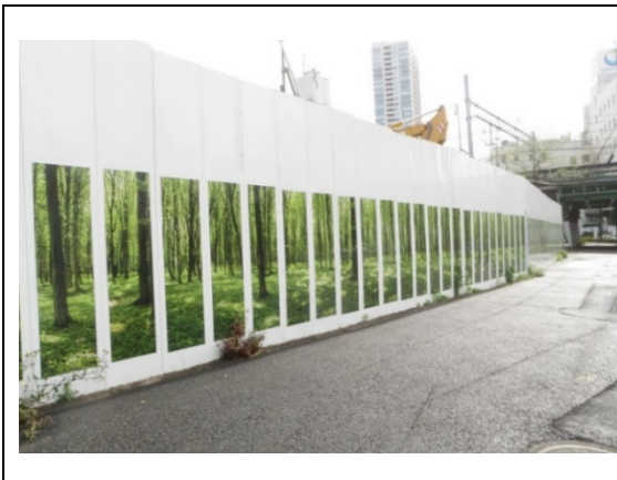
写真4-1-2-1 仮囲い・防音シート等の設置
