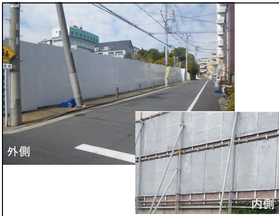
写真4-1-3-1 仮囲い・防音シート等の設置
