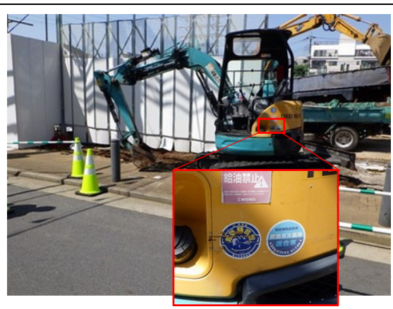
写真4-1-3-2 排出ガス対策型建設機械の採用、低騒音型建設機械の採用
