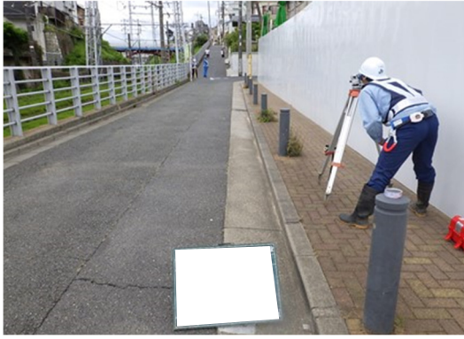
写真4-1-3-7 山留め材及び周辺地盤の計測管理
