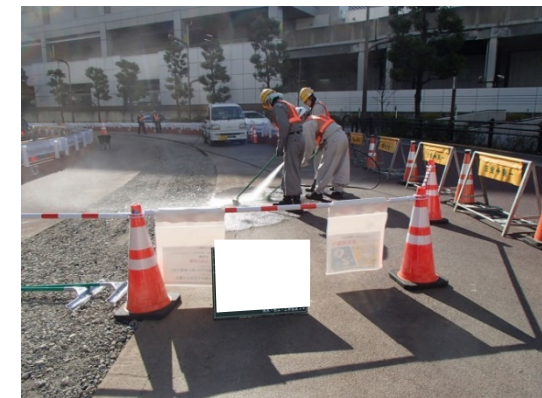
写真4-1-1-5 工事現場の清掃、散水
