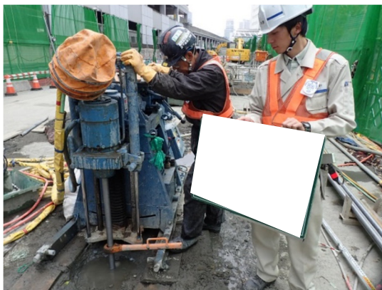
写真4-1-1-9 薬液注入工法における指針の順守
