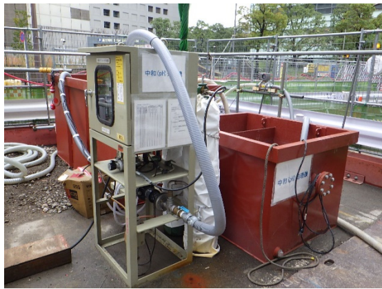
写真4-1-1-7 工事排水の適切な処理
