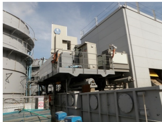
写真4-1-2-10 建設汚泥の脱水処理
