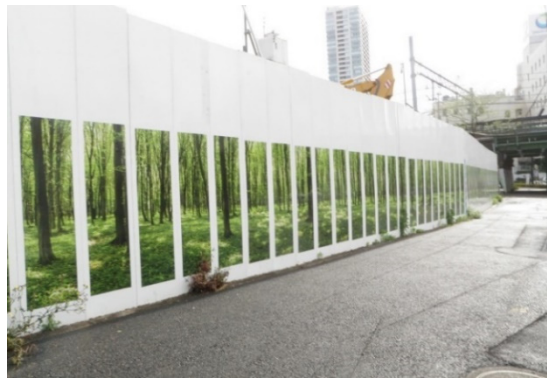
写真4-1-2-1 仮囲い・防音シート等の設置
