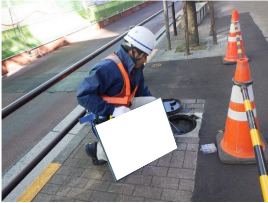
写真4-1-1-9 地下水の継続的な監視
