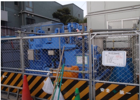
写真4-1-2-5 工事排水の適切な処理
