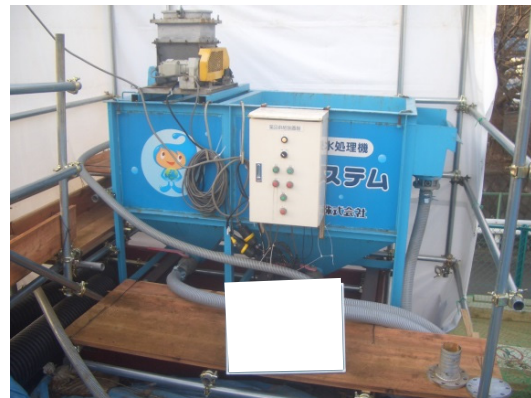
写真4-1-3-6 工事排水の適切な処理、 濁水処理施設及び仮設沈砂池の設置
