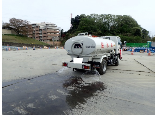
写真4-1-3-4 工事現場の清掃、散水
