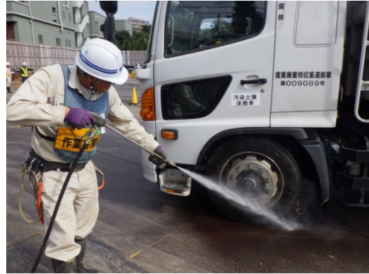
写真4-1-2-14 資材及び機械の運搬に用いる車両の出入口、周辺道路の清掃及び散水、タイヤの洗浄
