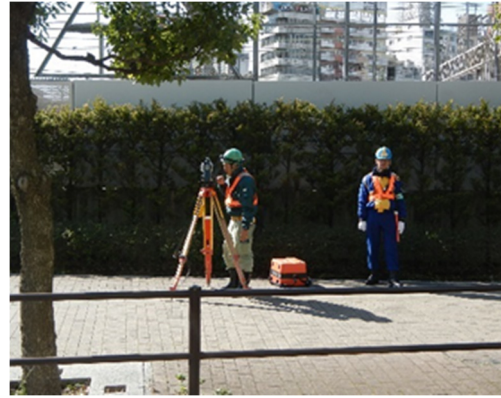
写真4-1-1-10 山留め材及び周辺地盤の計測管理
