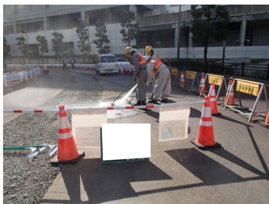
写真4-1-1-5 工事現場の清掃、散水
