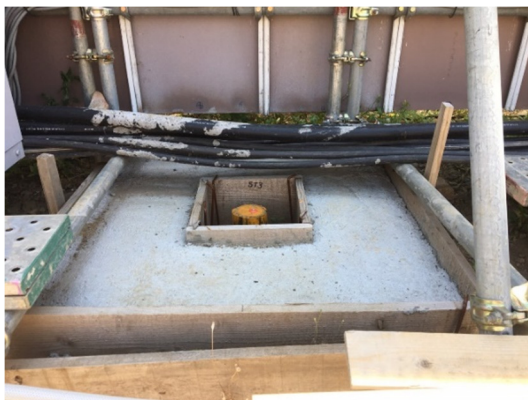
写真4-1-2-9 山留め材及び周辺地盤の計測管理
