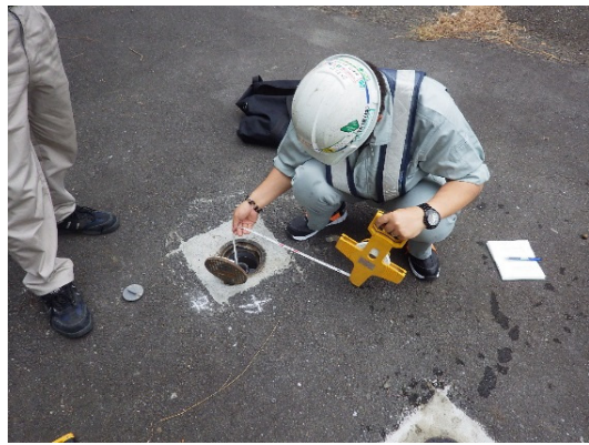
写真4-1-3-8 地下水の継続的な監視
