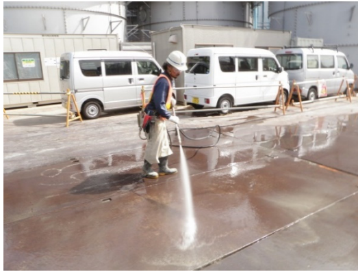
写真4-1-2-3 工事現場の清掃、散水
