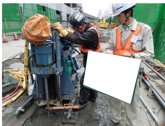
写真4-1-1-8 薬液注入工法における指針の順守
