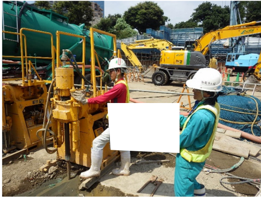
写真4-1-2-7 薬液注入工法における指針の順守
