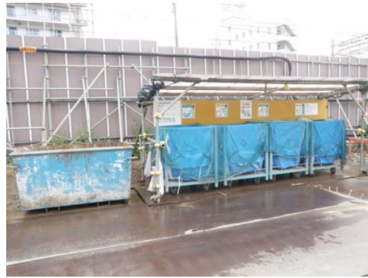
写真4-1-2-12 副産物の分別、再資源化
