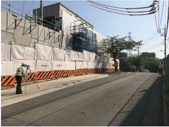
写真4-1-3-9 山留め材及び周辺地盤の計測管理
