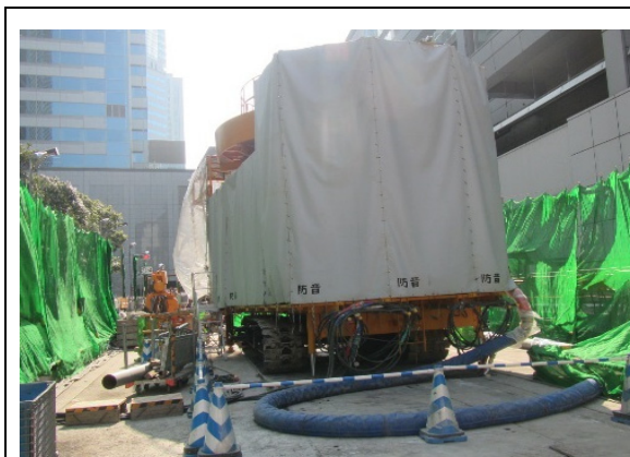
写真4-1-1-1 仮囲い・防音シート等の設置
