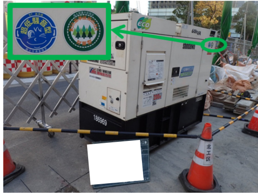
写真4-1-1-3 低騒音型建設機械の採用
