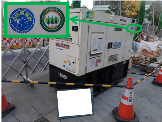
写真4-1-1-3 低騒音型建設機械の採用
