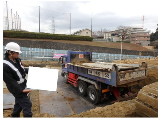
写真4-1-3-12 荷台への防じんシート敷設及び散水
