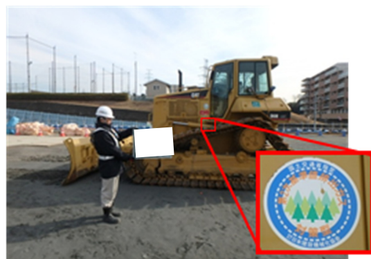
写真4-1-3-2 排出ガス対策型建設機械の採用
