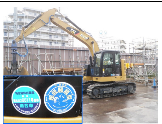
写真4-1-2-2 排出ガス対策型建設機械の採用、低騒音型建設機械の採用
