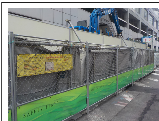
写真4-1-1-1 仮囲い・防音シート等の設置
