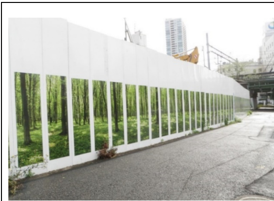
写真4-1-2-1 仮囲い・防音シート等の設置
