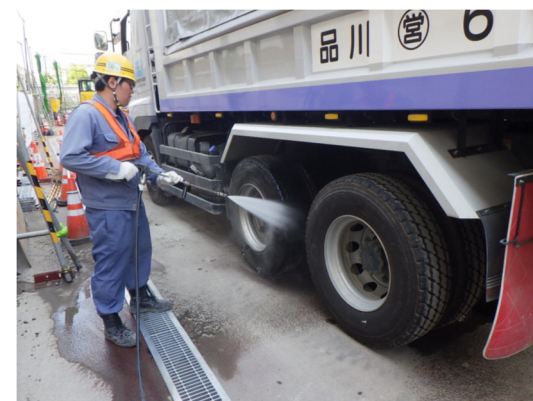
写真4-1-1-14 資材及び機械の運搬に用いる車両の出入口、周辺道路の清掃及び散水、タイヤの洗浄
