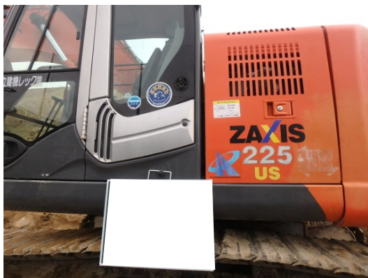
写真4-1-3-3 低騒音型建設機械の採用
