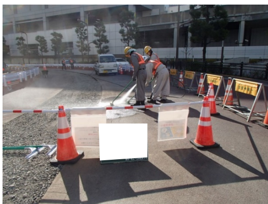
写真4-1-1-5 工事現場の清掃、散水
