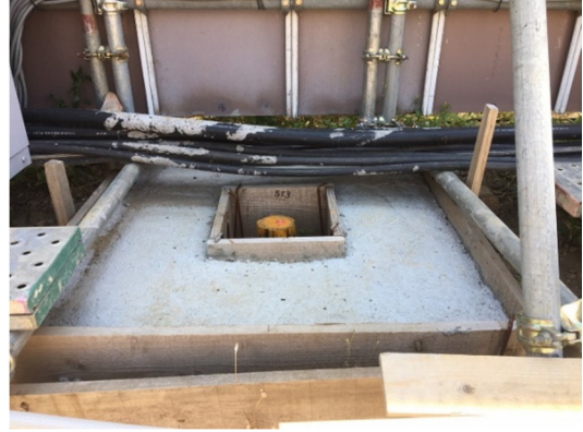
写真4-1-2-6 山留め材及び周辺地盤の計測管理
