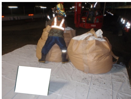
写真4-1-1-7 ヤード内で一時的に存置する発生土の適切な管理
