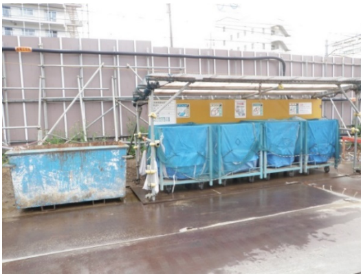
写真4-1-2-9 副産物の分別、再資源化
