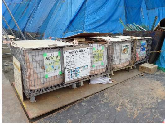
写真4-1-3-11 副産物の分別、再資源化
