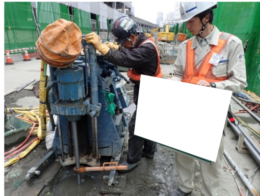
写真4-1-1-8 薬液注入工法における指針の順守
