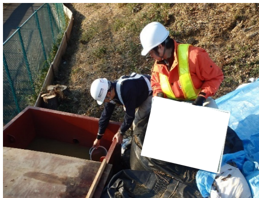
写真4-1-3-7 工事排水の監視
