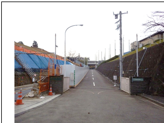
写真4-1-3-1 仮囲い・防音シート等の設置
