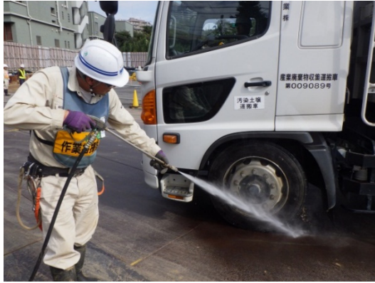
写真4-1-2-11 資材及び機械の運搬に用いる 車両の出入口、周辺道路の清掃及び散水、タイ ヤの洗浄
