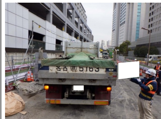
写真4-1-1-13 荷台への防じんシート敷設及び散水
