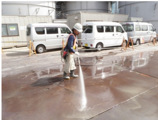
写真4-1-2-3 工事現場の清掃、散水
