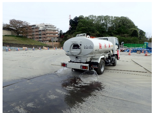
写真4-1-3-4 工事現場の清掃、散水
