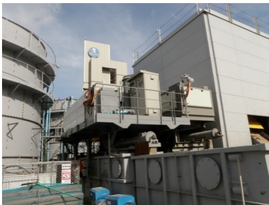
写真4-1-2-7 建設汚泥の脱水処理
