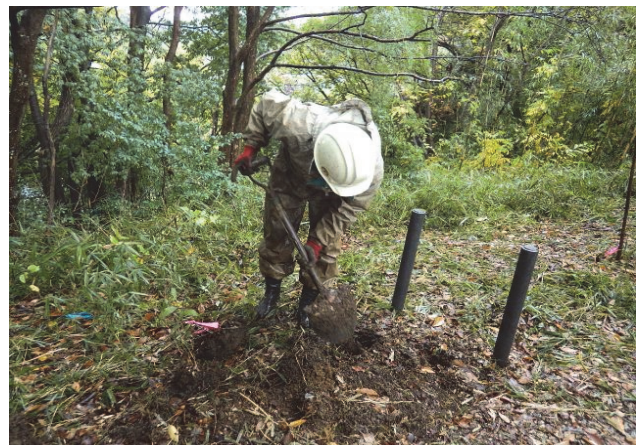
写真 3-2-6 移植作業の状況 (ササバギンラン)
