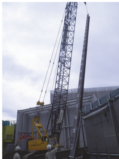
図 2-4(2) 地下設備棟土留壁工の施工手順
