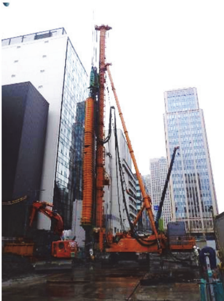
図 2-4(2) 地下設備棟土留壁工の施工手順
