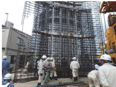
図 2-4(4) 非常口土留壁工の施工手順
