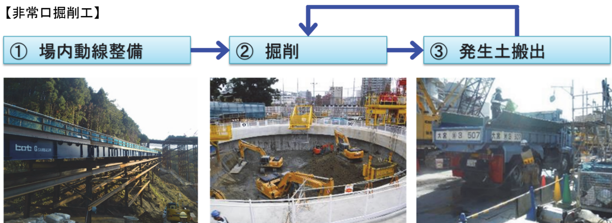
図 2-4(6) 非常口掘削工の施工手順
