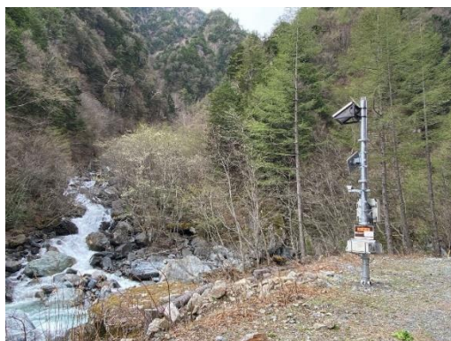
図40.監視カメラによる流況の常時監視状況 (悪沢)
