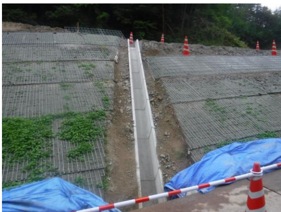
図12 盛土施工中の排水設備
