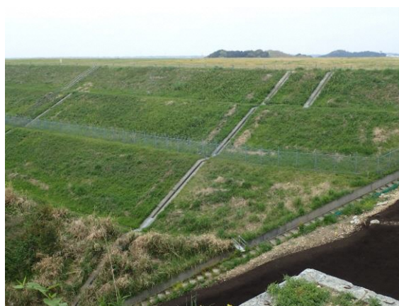
図13 盛土完成後の排水設備
