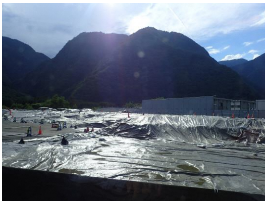
図 1 6 施工途中の遮水シート
