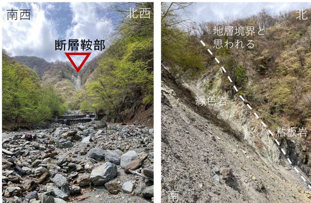
写真 3 調査 2 地点断層鞍部遠望と露頭状況
