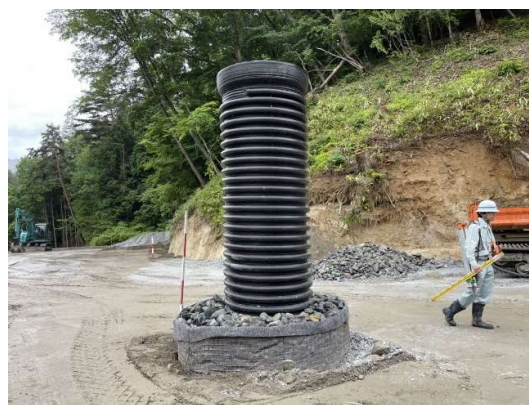
写真 2 水平排水工及び縦排水工の例
