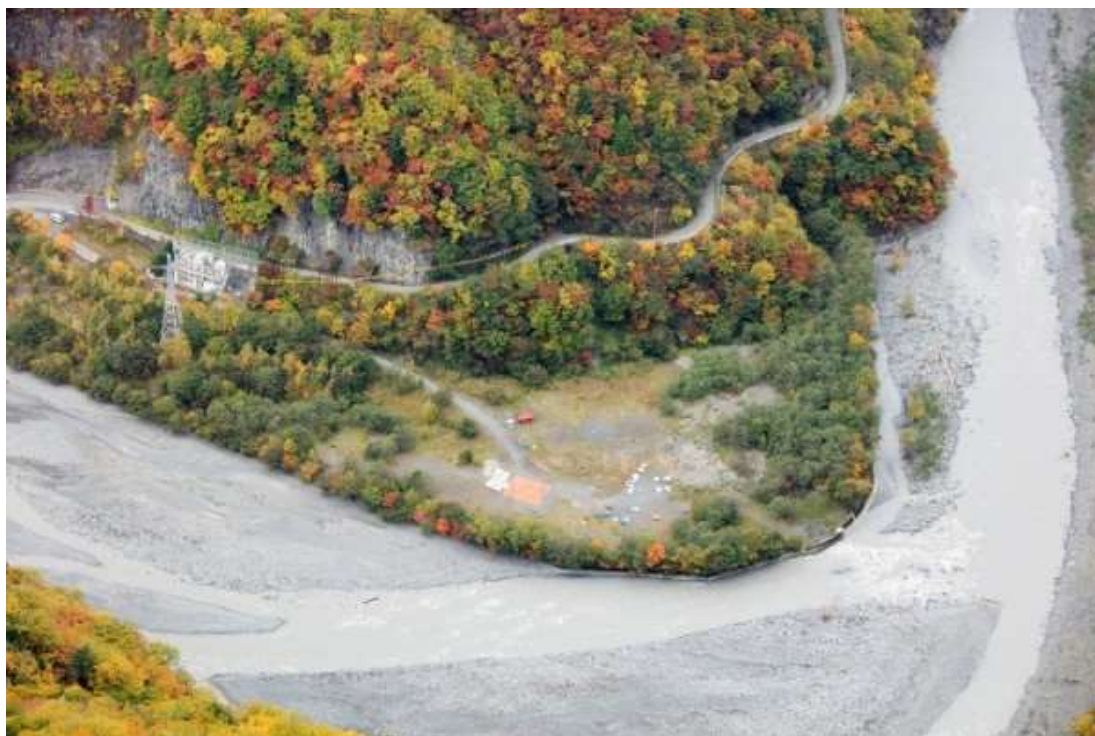
写真 5 剝石発生土置き場現地状況
