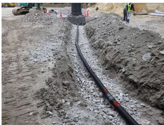
写真 2 水平排水工及び縦排水工の例
