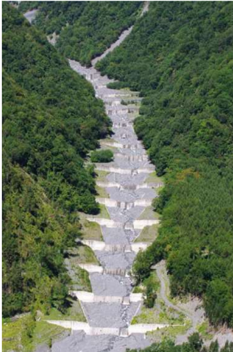
写真 6 上千枚沢の治山ダム
