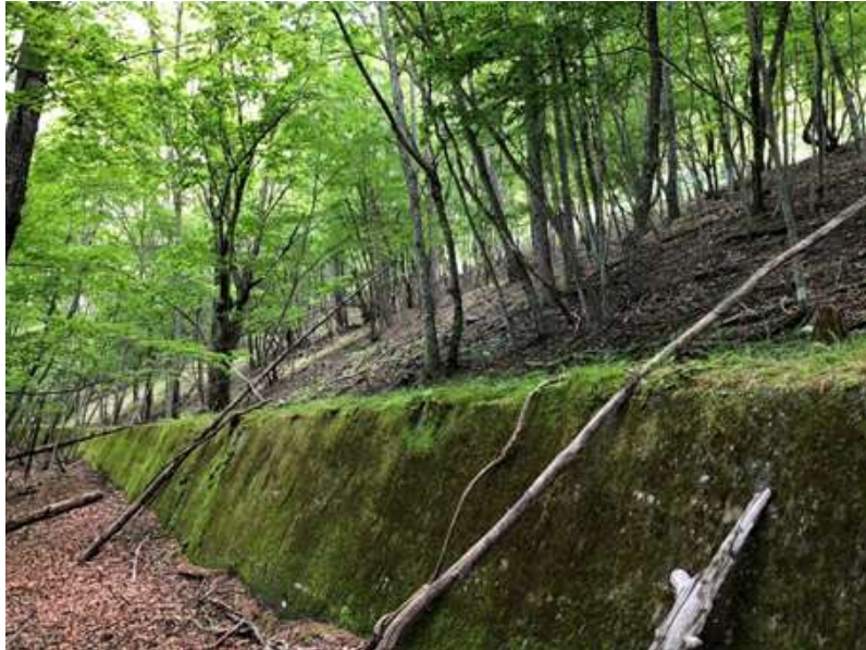
写真 4 藤島発生土置き場現地状況
