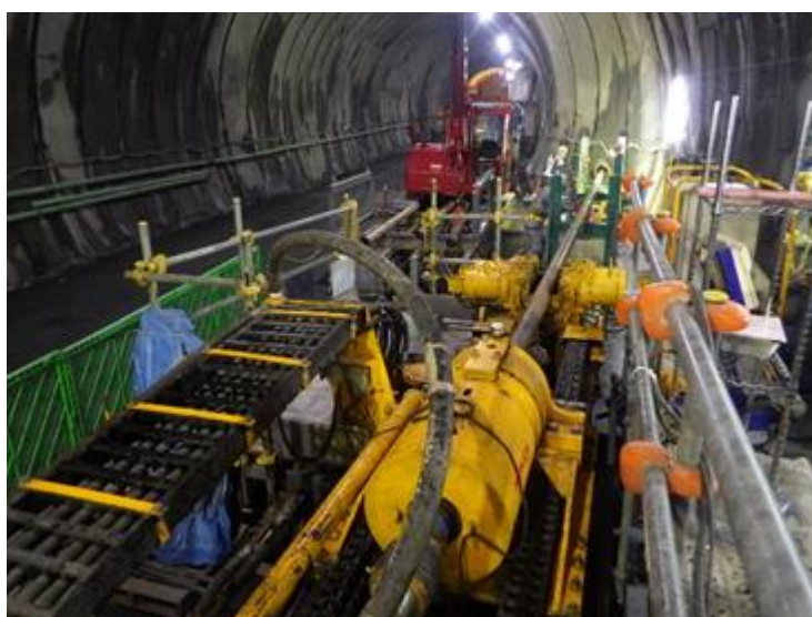
写真 4.1 高速長尺先進ボーリング施工写真（山梨工区）
