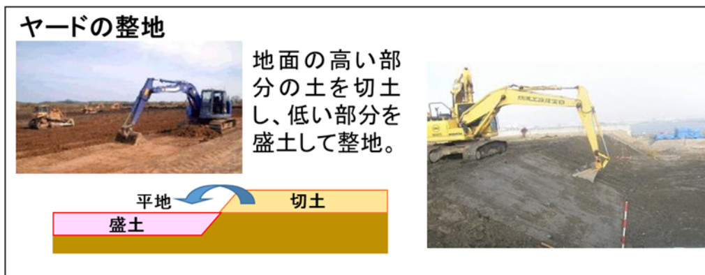
図 2-3 ヤード整地（写真は類似工事の例）
