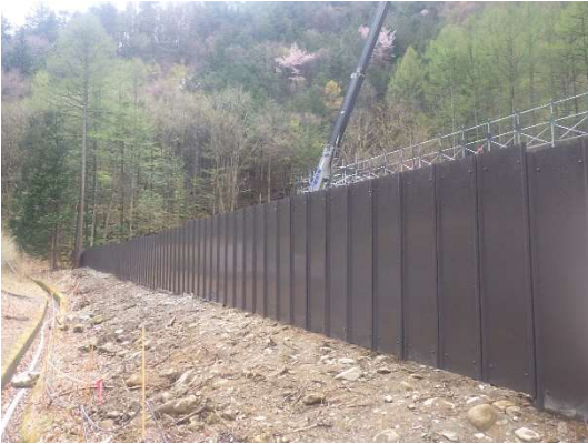
写真 5-1-1(1) 仮囲い（安全鋼板）の設置状況
