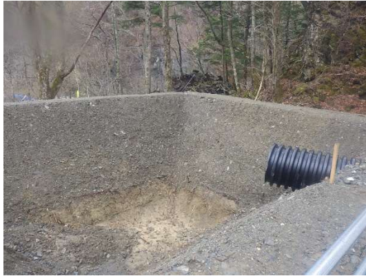
写真 5-1-6 仮設沈砂池の設置状況
