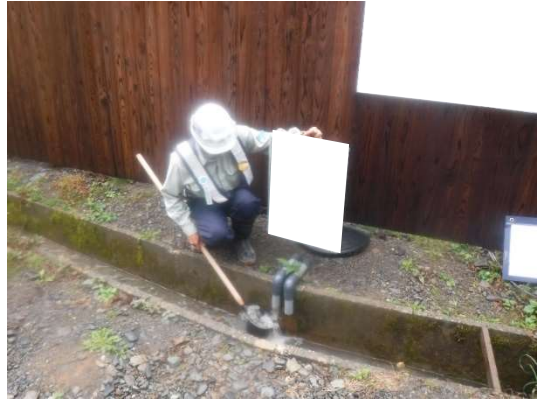
写真 5-1-7 工事排水の監視状況
