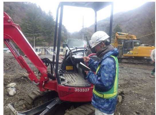
写真 5-1-3 建設機械の点検状況
