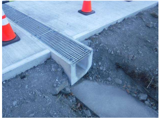
写真 5-1-10(2) 排水溝（側溝、横断溝）の設置状況
