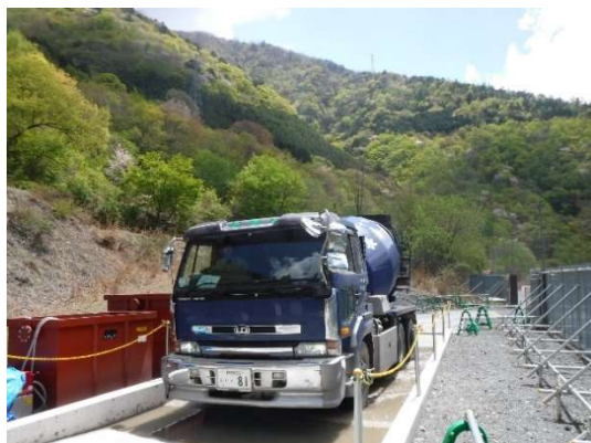
写真 5-1-11 タイヤ洗浄の実施状況
