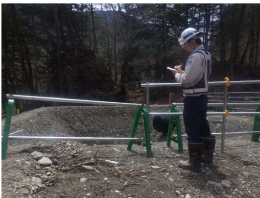
写真 5-1-8 処理設備の点検状況
