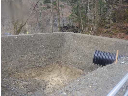
写真 5-1-6 仮設沈砂池の設置状況 (一例)
