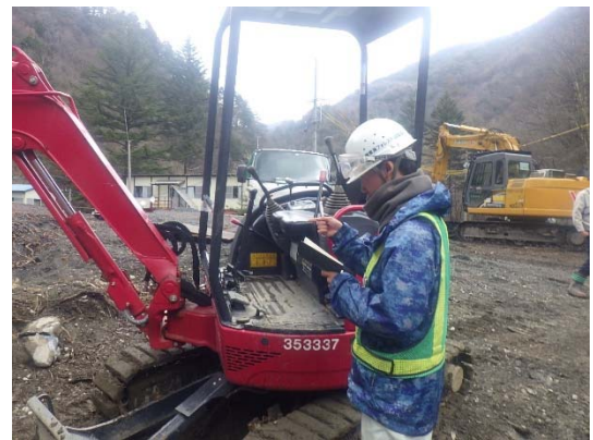
写真 5-1-3 建設機械の点検状況（一例）
