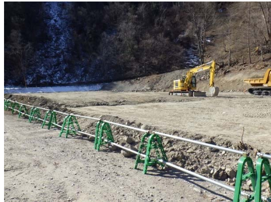
写真 5-1-12 建設発生土の再利用状況 (一例)
