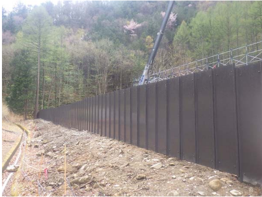
写真 5-1-1(1) 仮囲い（安全鋼板）の設置状況（一例）
