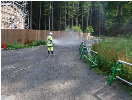
写真 5-1-4 工事現場の散水状況（一例）
