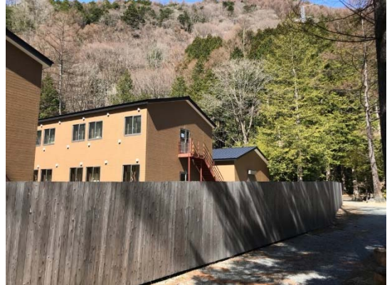
写真 5-1-1(2) 仮囲い（木製）の設置状況（一例）
