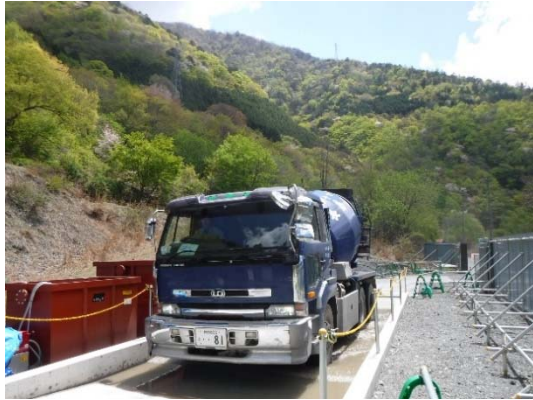
写真 5-1-11 タイヤ洗浄の実施状況 (一例)
