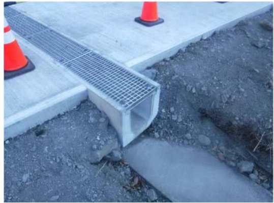
写真 5-1-10(2) 排水溝(側溝、横断溝)の 設置状況(一例)
