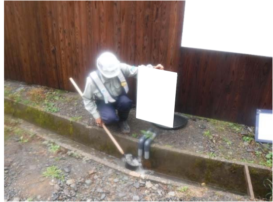
写真 5-1-7 工事排水の点検状況 (一例)
