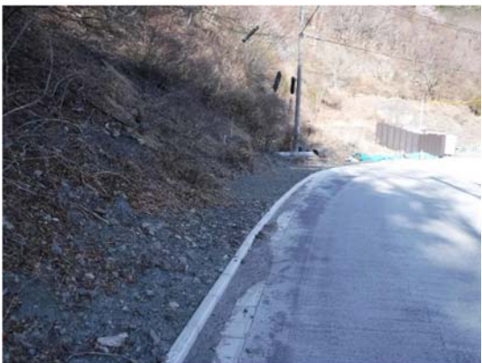
写真 5-1-15 林道の舗装状況 1) (一例)
