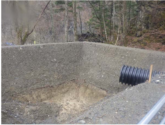
写真 5-1-6 仮設沈砂池の設置状況 (一例)
