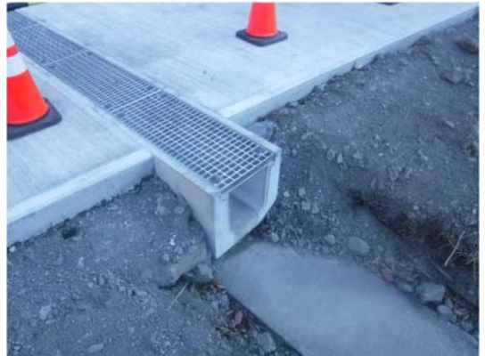
写真 5-1-10(2) 排水溝(側溝、横断溝)の 設置状況(一例)
