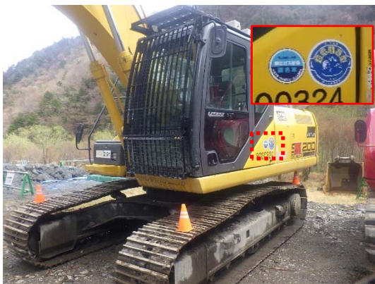
写真 5-1-2 排出ガス対策型、低騒音型建設機械の採用（一例）
