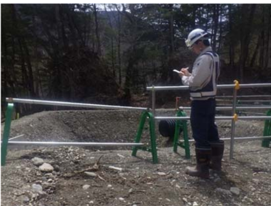
写真 5-1-8 処理設備の点検状況 (一例)
