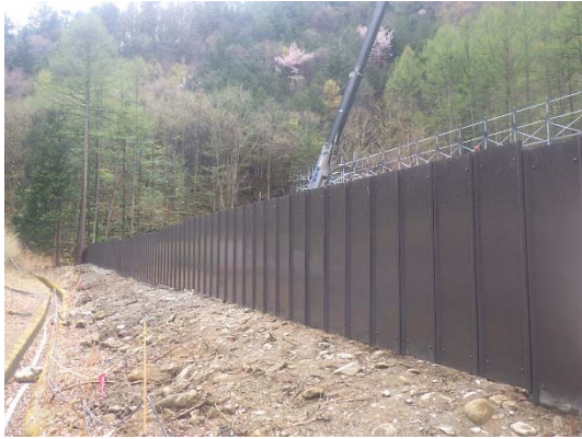
写真 5-1-1(1) 仮囲い（安全鋼板）の設置状況（一例）
