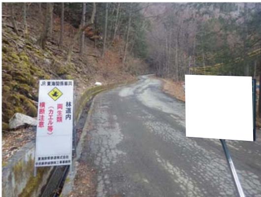
写真 5-1-10(1) 注意看板の設置状況 (一例)
