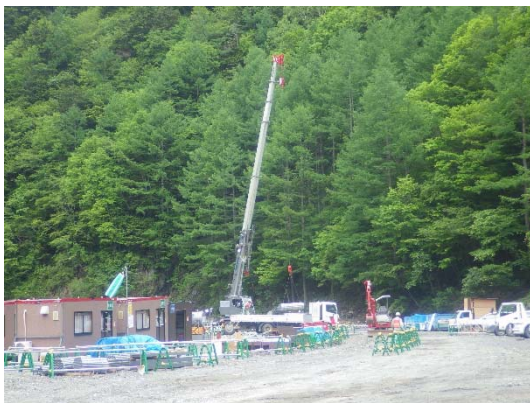
クレーン作業状況
