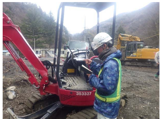
写真 5-1-3 建設機械の点検状況（一例）
