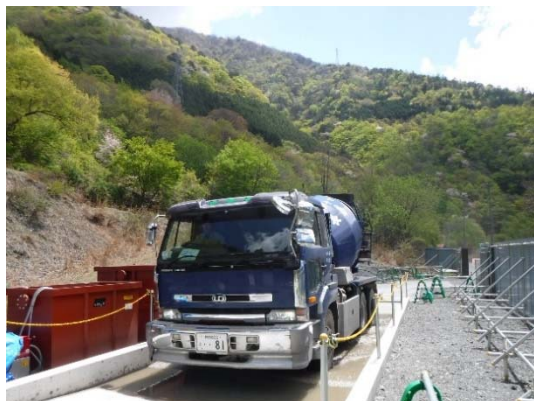
写真 5-1-11 タイヤ洗浄の実施状況 (一例)
