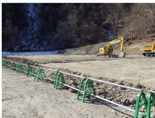
写真 5-1-13 建設発生土の再利用状況 (一例)
