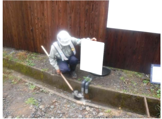
写真 5-1-7 工事排水の点検状況 (一例)
