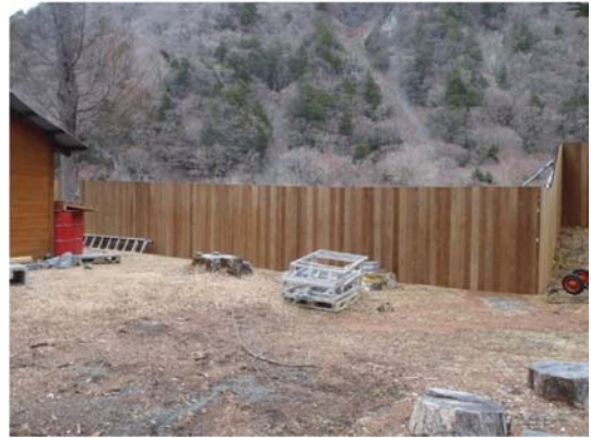
写真 5-1-1(2) 仮囲い（木製）の設置状況（一例）
