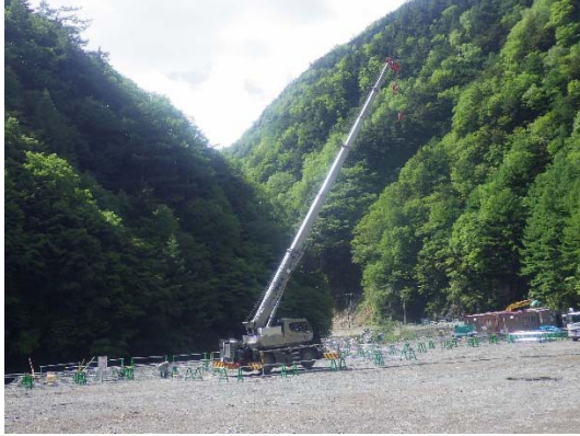
クレーン設置状況
