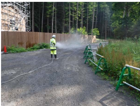
写真 5-1-4 工事現場の散水状況（一例）
