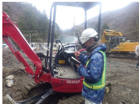
写真 4-1-3 建設機械の点検状況（一例）
