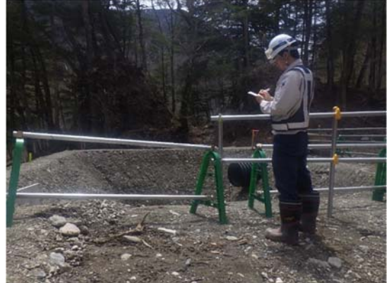
写真 4-1-7 仮設沈砂池の点検状況 (一例)
