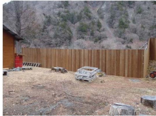
写真 4-1-1(2) 仮囲い（木製）の設置状況（一例）
