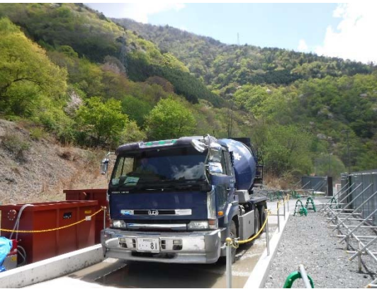
写真 4-1-8 タイヤ洗浄の実施状況 (一例)
