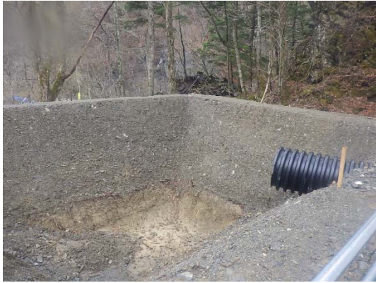
写真 4-1-6 仮設沈砂池の設置状況 (一例)
