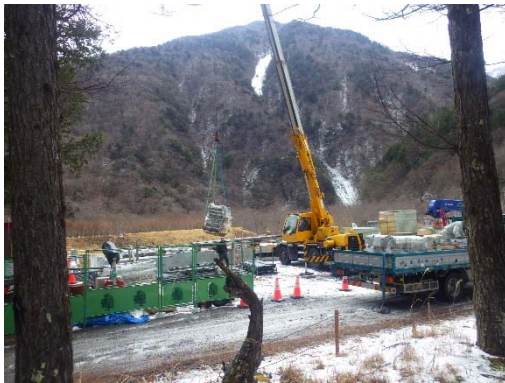
クレーン作業状況
