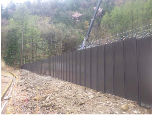
写真 4-1-1(1) 仮囲い（安全鋼板）の設置状況（一例）
