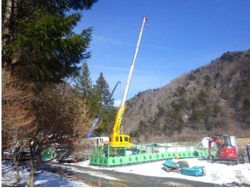
クレーン設置状況
