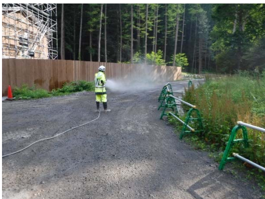
写真 4-1-4 工事現場の散水状況（一例）
