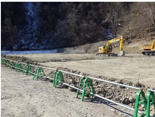
写真 4-1-10 建設発生土の再利用状況 (一例)
