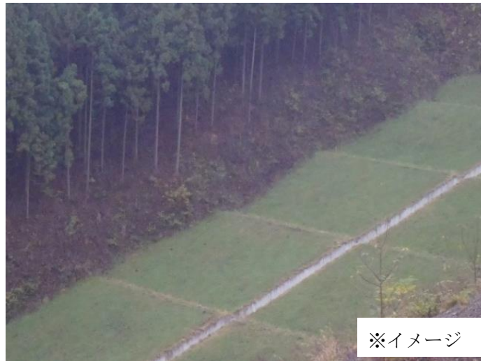
図 5-1 植生による法面保護工
