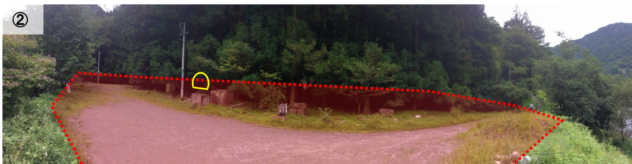
図 2-3 除山非常口の現況
