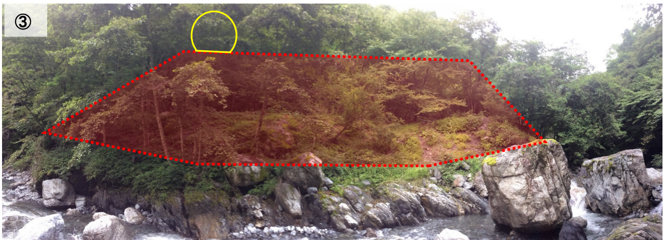
図 2-4 釜沢非常口の現況
