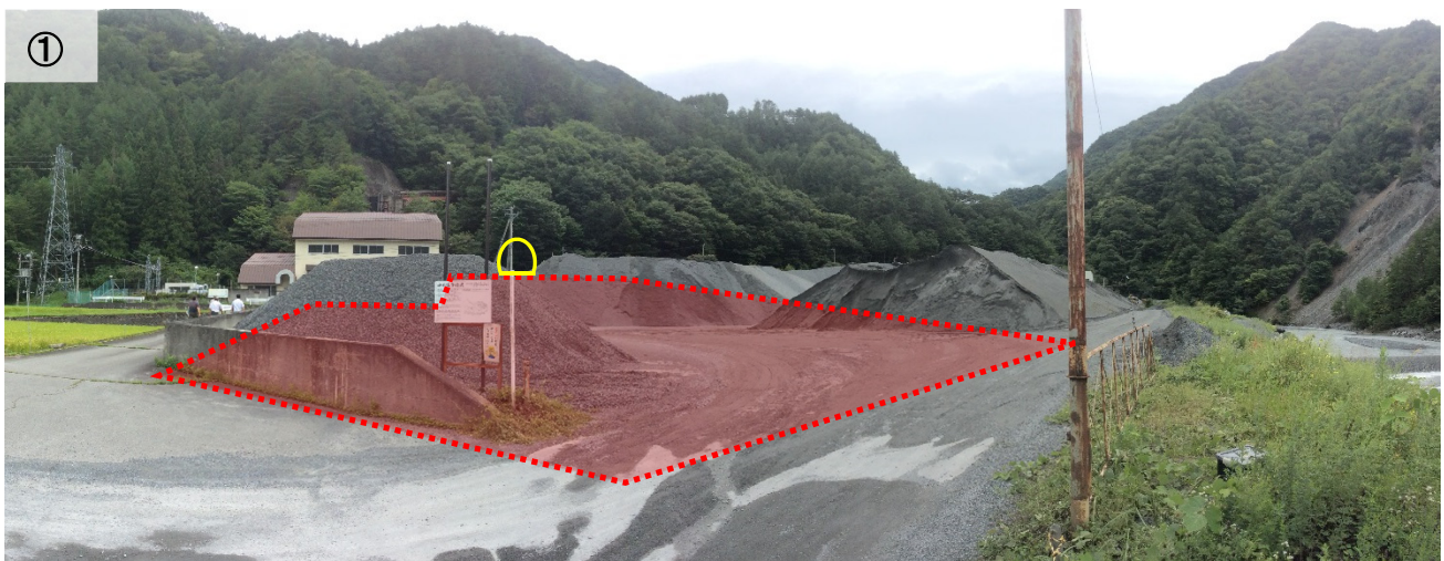
図 2-2 小渋川非常口の現況
