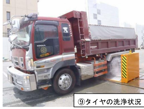
図 3-10 資材及び機械の運搬に用いる車両の運行による影響を低減させるための環境保全措置
