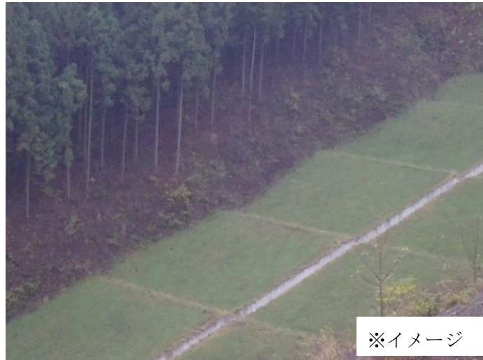
図 5-1 植生による法面保護工
