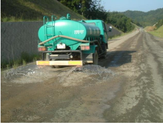
写真② 周辺道路の散水・清掃状況、タイヤ洗浄機の設置
