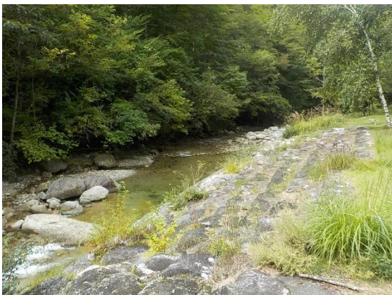
周辺河川整備状況
