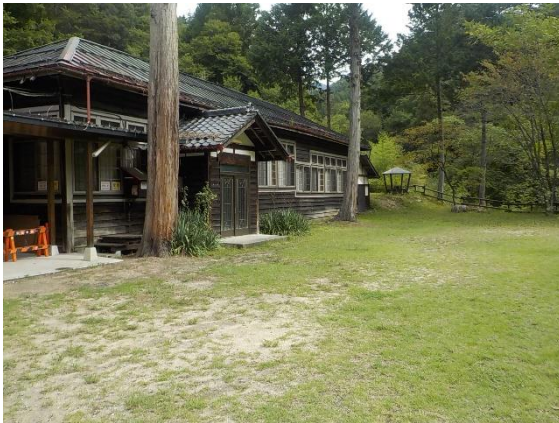
宿泊施設（旧校舎）の状況
