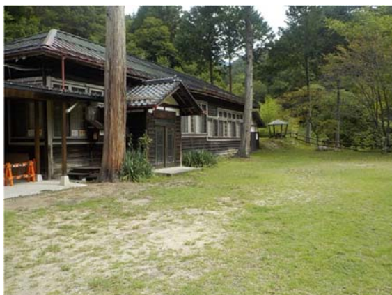
宿泊施設（旧校舎）の状況
