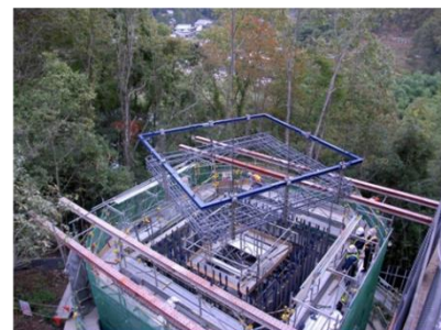
⑤ 橋脚部鉄筋組立
