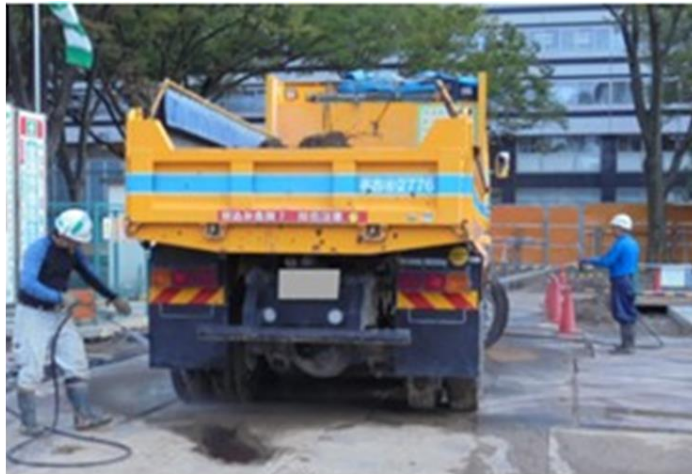
タイヤ洗浄の状況
