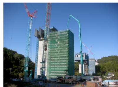
⑥ 橋脚部コンクリート打設
