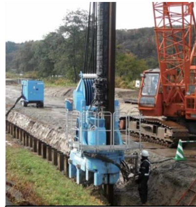
① 鋼矢板打込み
