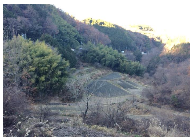
発生土置き場（睦沢）計画地の現況（2） （道の駅から発生土置き場を望む）
